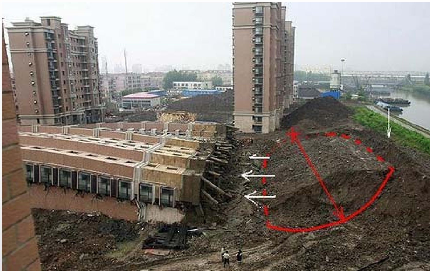
Chung cư 13 tầng Trung Quốc
