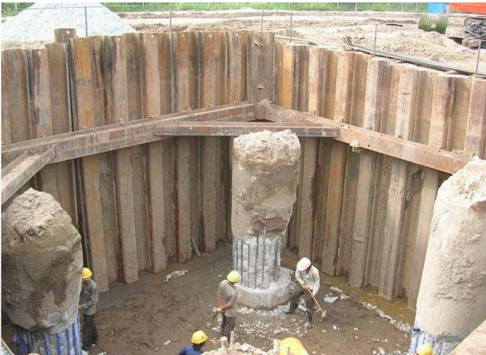
Đập đầu cọc
