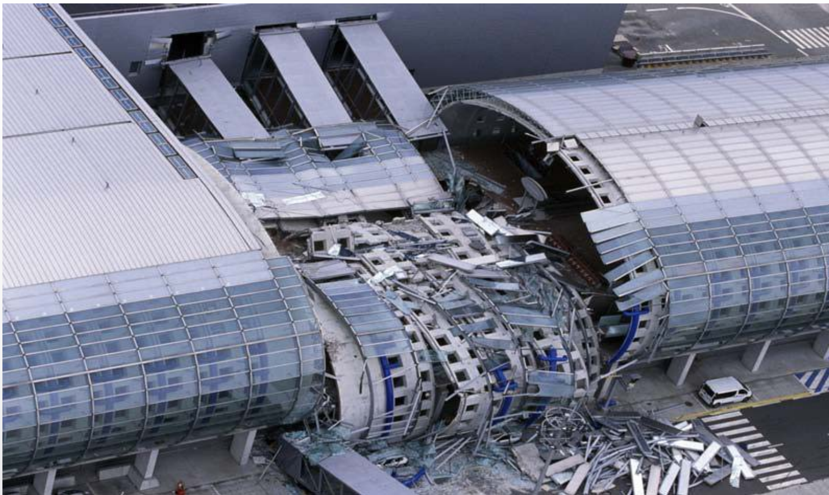
Sự cố sập đổ công trình sân bay Charles de Galle, 2004
