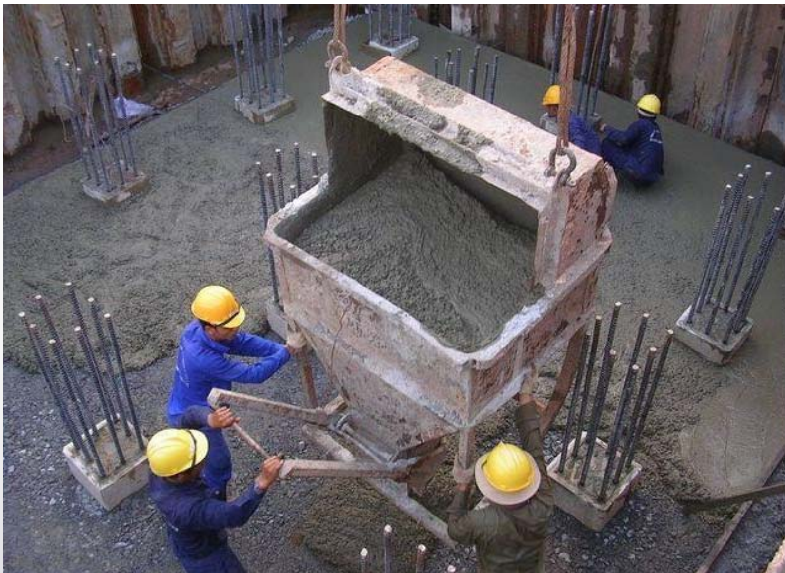
Đổ bê tông lót móng
