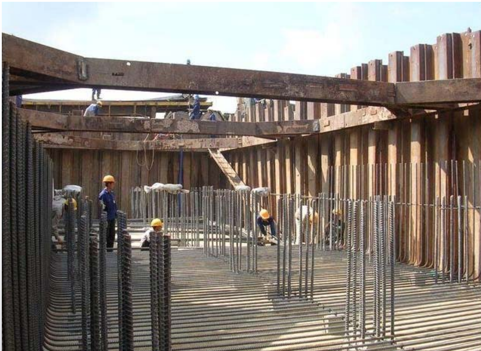
Thi công thép đài cọc
