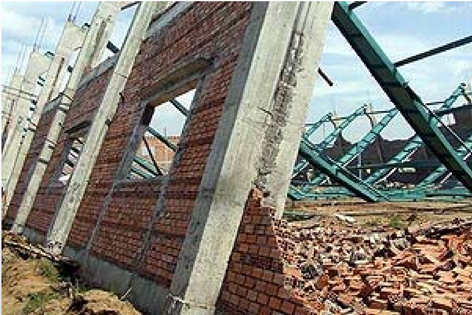
Nhà xưởng CT may Hòa Khánh
