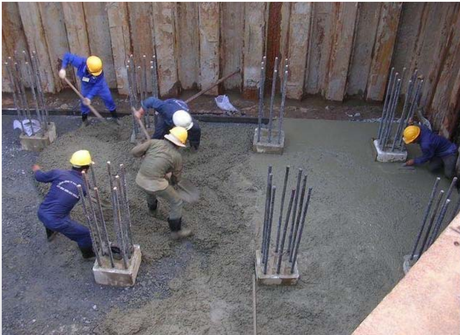
Đổ bê tông lót móng
