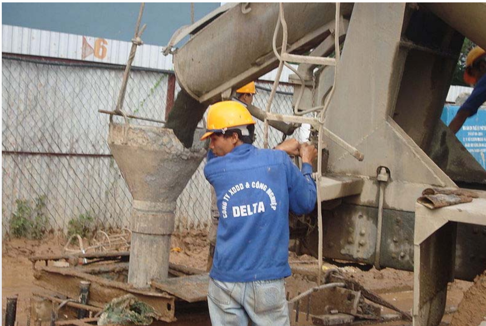
Đổ bê tông cọc
