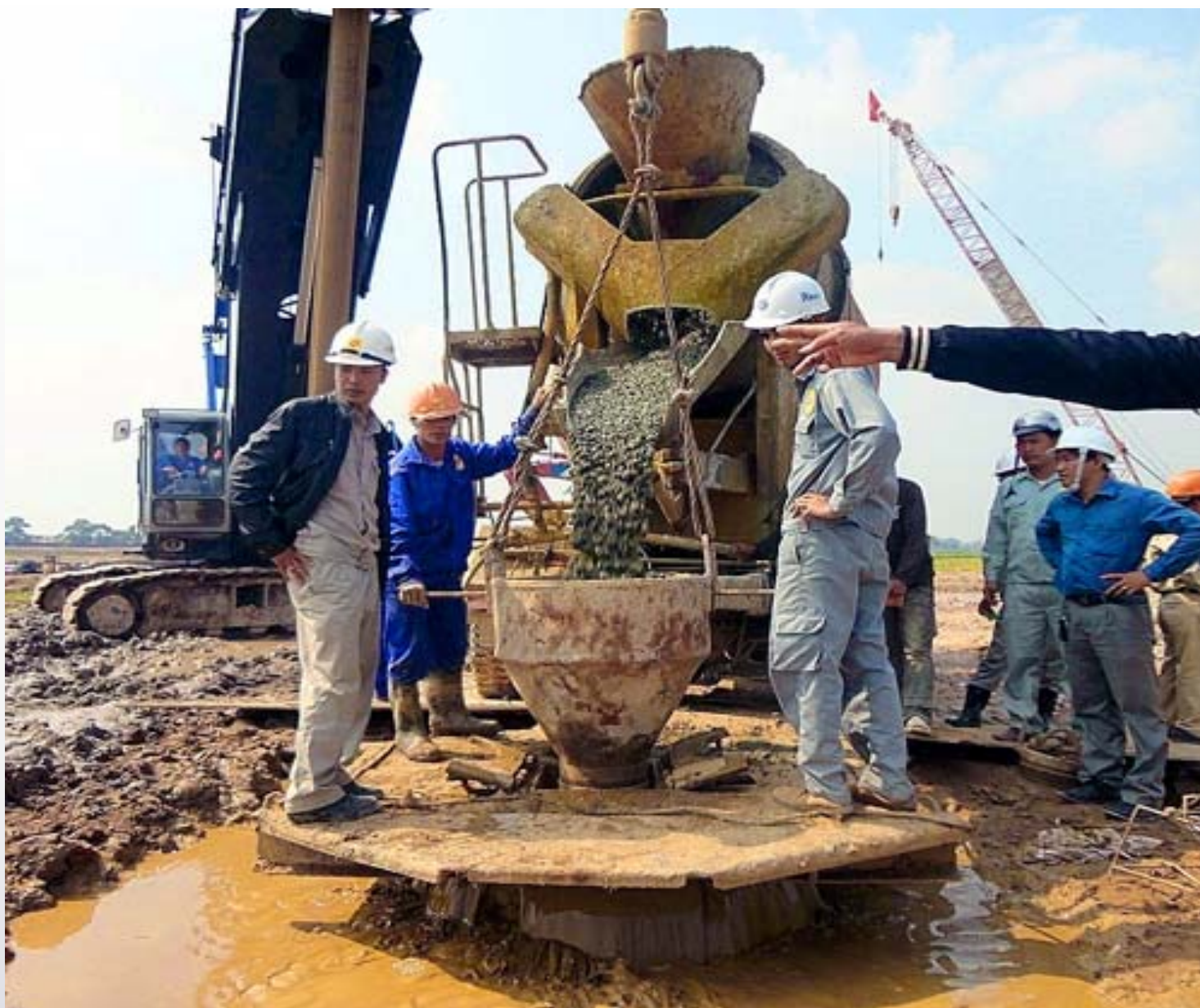
Đổ bê tông cọc
