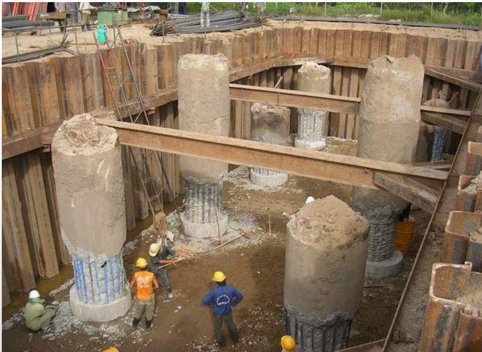
Đập đầu cọc
