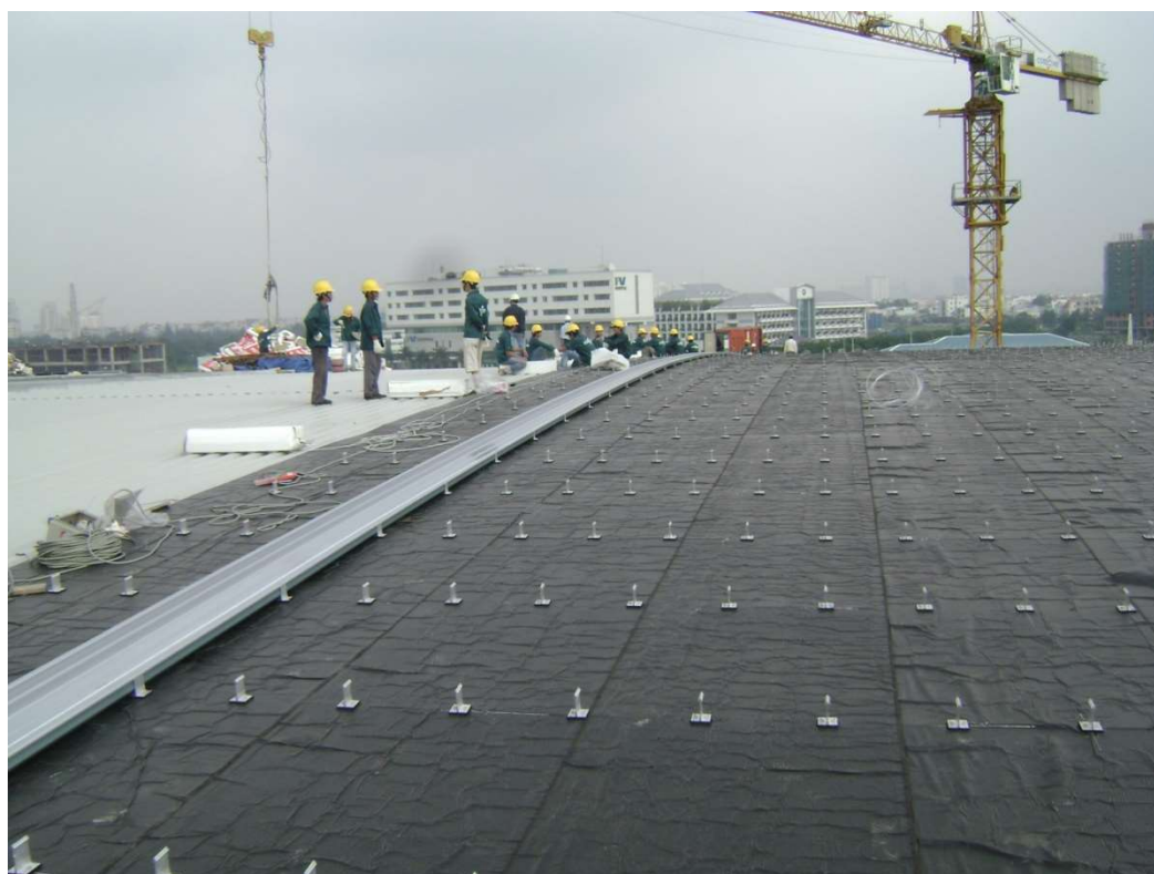
Lắp dựng tấm lợp trên cùng
