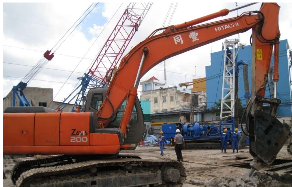
Máy đào đất dùng đục bê tông nền
