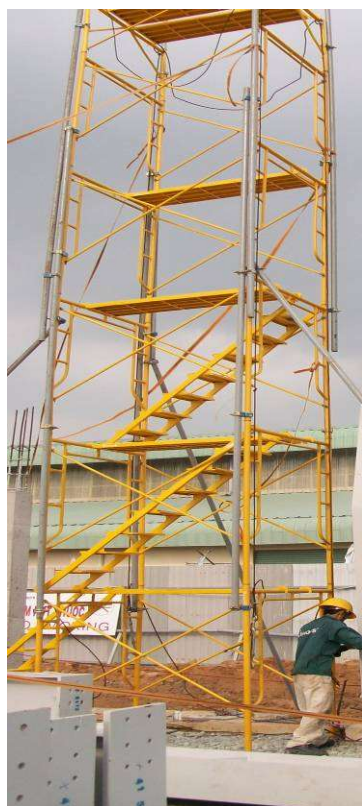
Chuẩn bị dàn giáo và lan can an toàn trước khi lắp dựng
