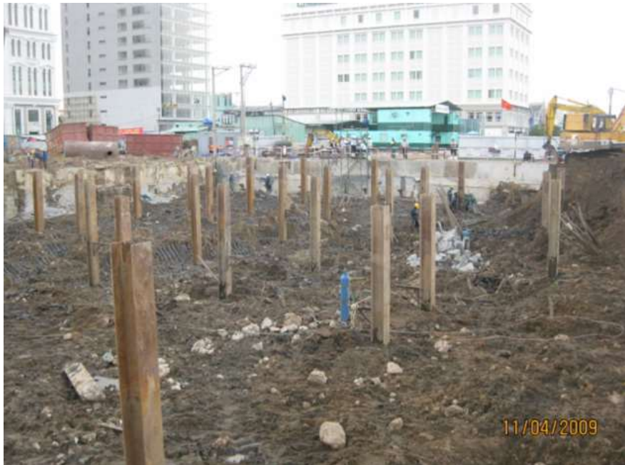
Hạ cốt đất đến vị trí lắp hệ giằng
