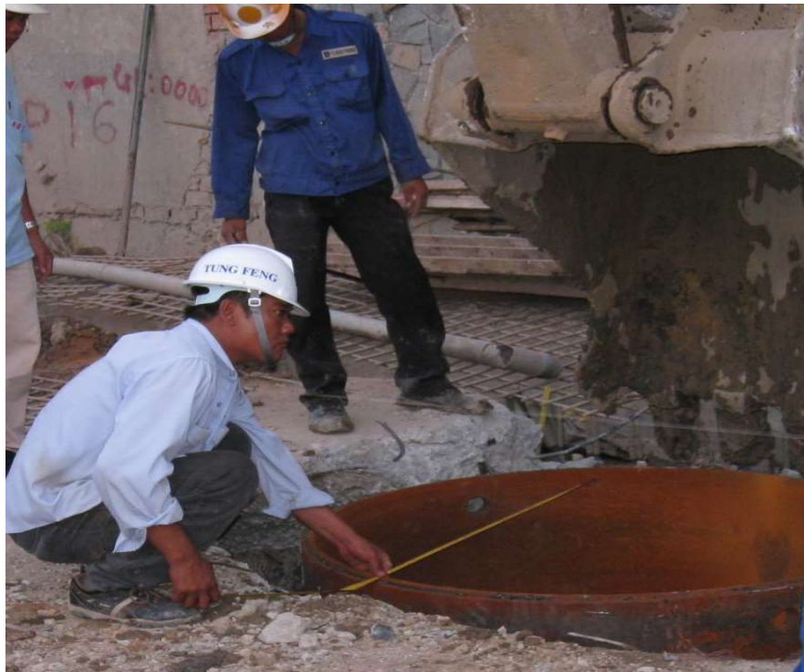
Kiểm tra tọa độ ống vách sau khi được hạ bằng thước dây
