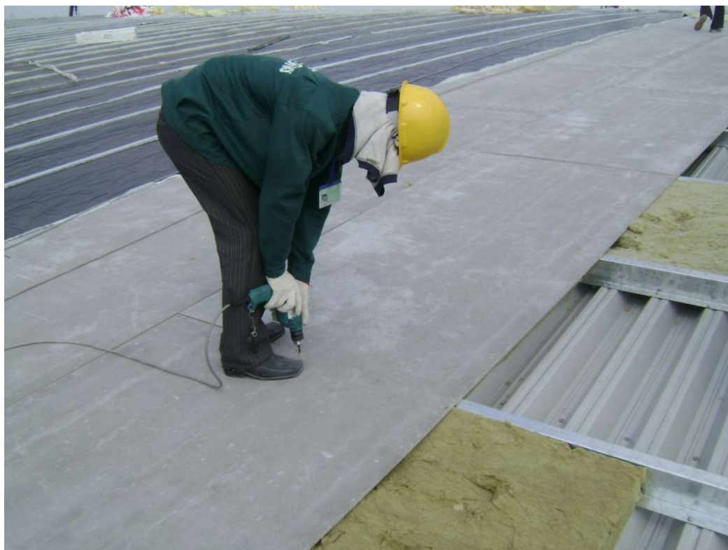
Lắp dựng tấm cement board
