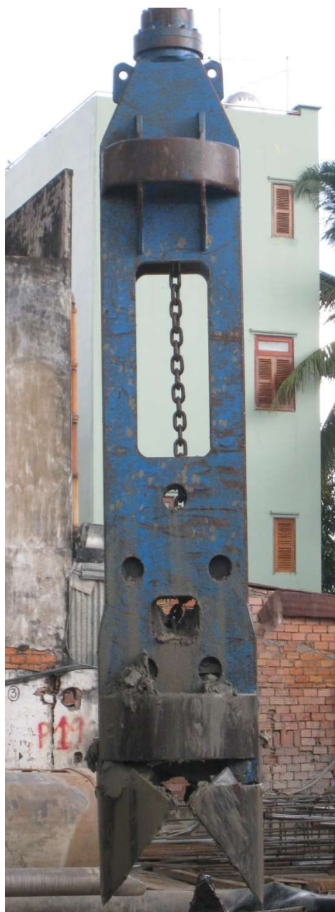
Mũi cạp đất để hạ casing.
