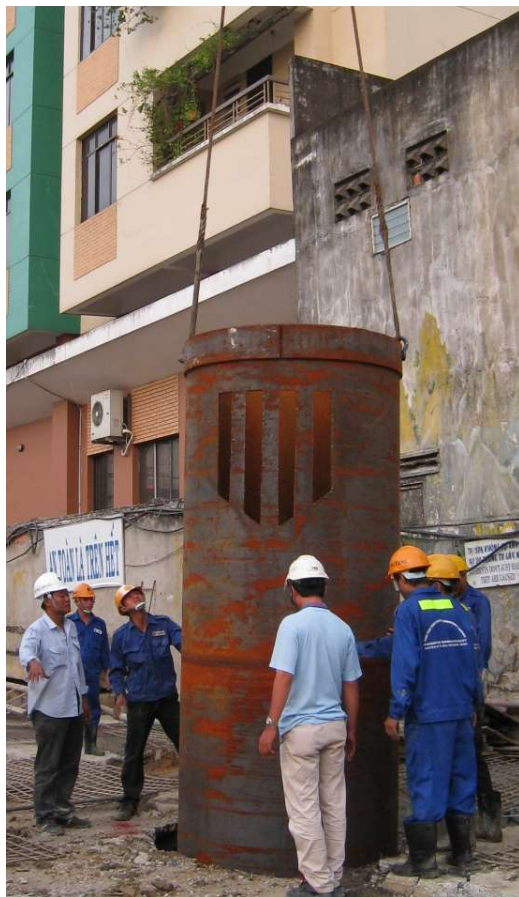
Ống vách được hạ bằng cầu bánh xích vào vị trí cần khoan.
