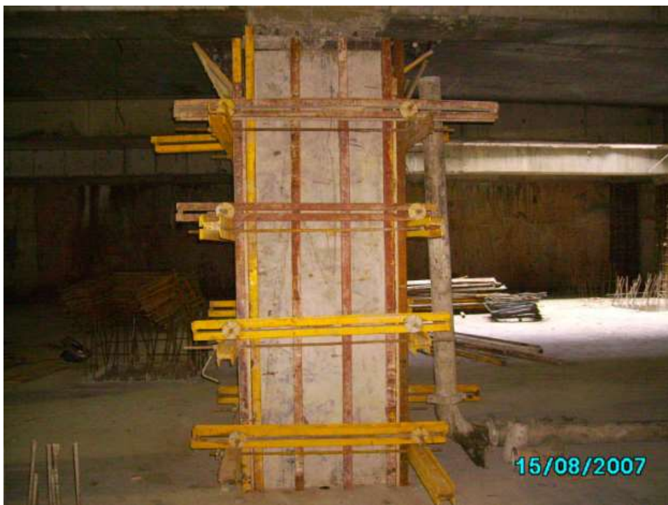
Cốp pha, bê tông cột sàn hầm 1
