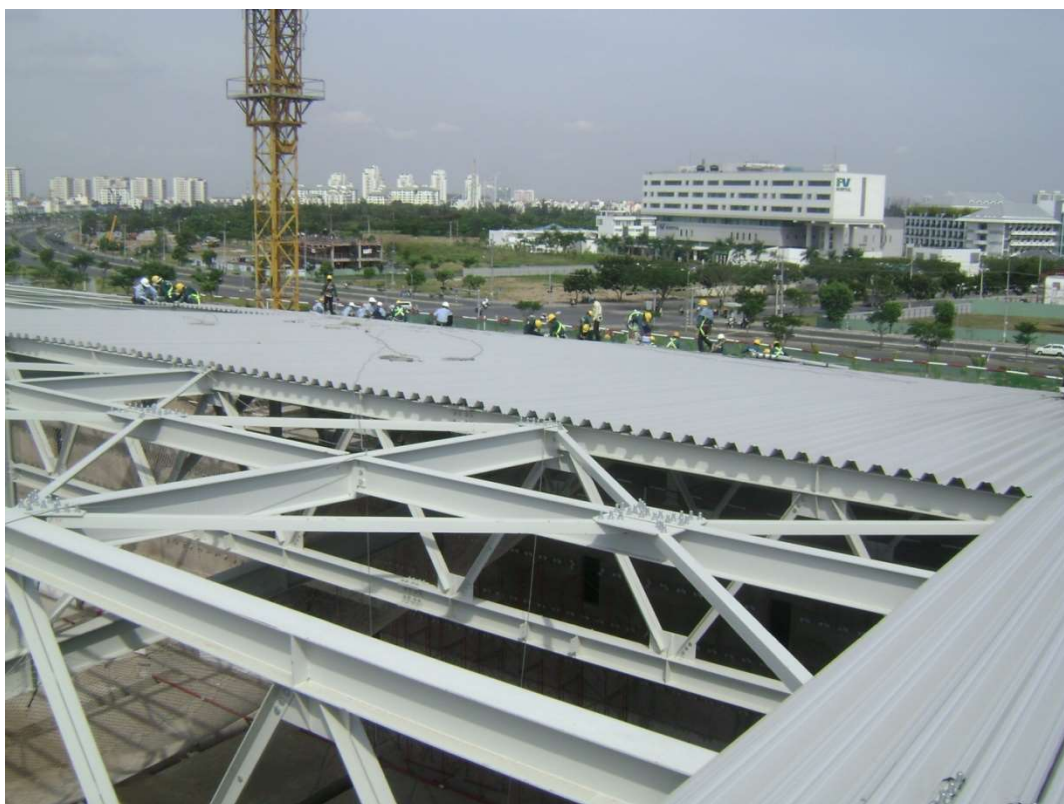
Thi công tấm Decking
