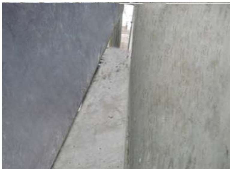
Cốp pha sau khi được định vị vào vị trí mới
