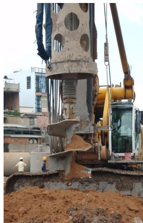
Khoan tạo lỗ của phương pháp khoan dung dịch
