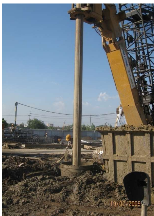
Khoan tạo lỗ của phương pháp khoan dung dịch
