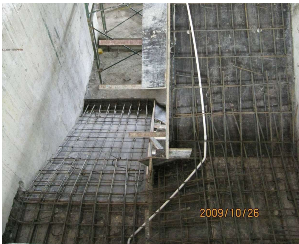
Gia công lắp dựng cốt thép
