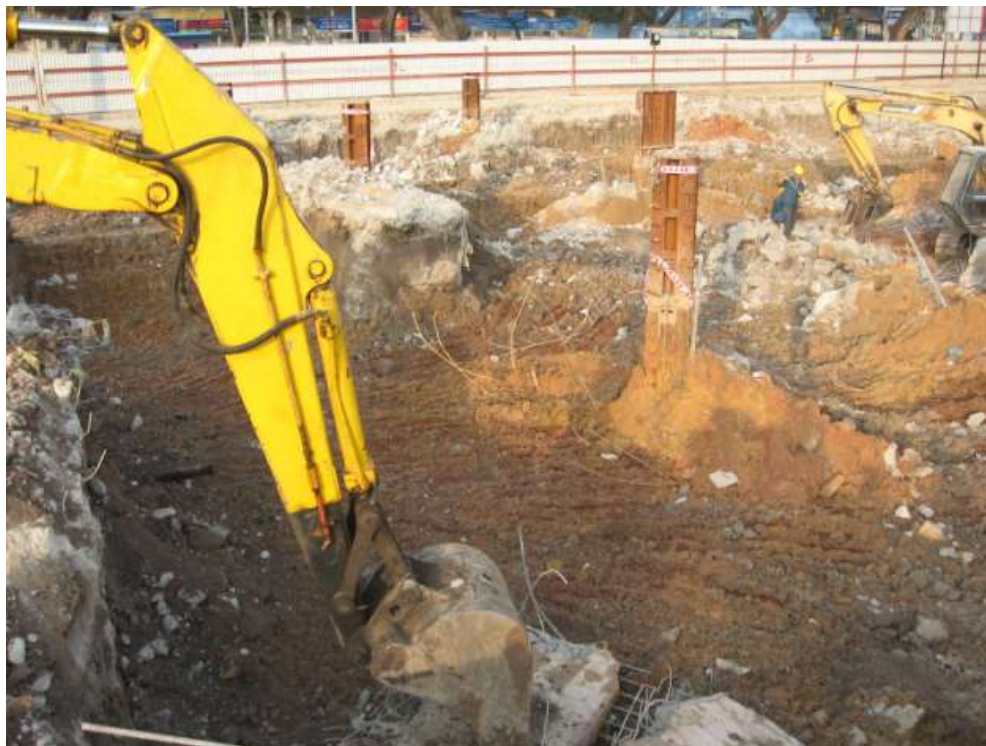
Đào đất thi công sàn trệt
