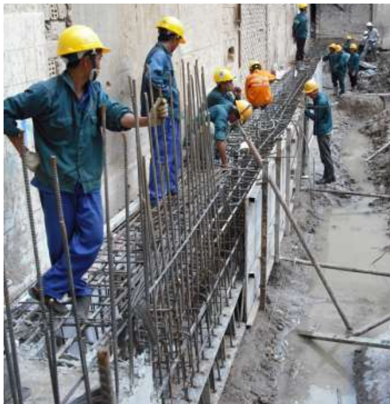
Thi công dầm giằng cọc vây
