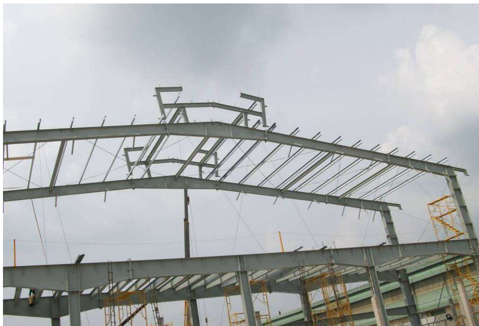
Lắp xà gồ và thanh giằng thành hệ cứng
