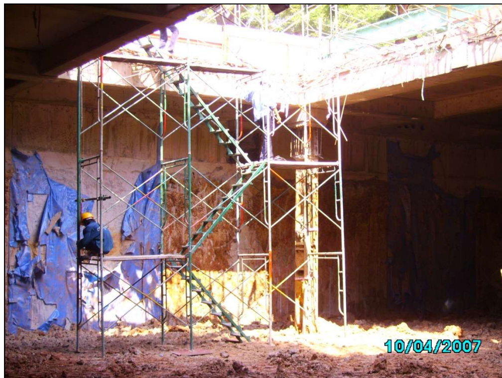
Bố trí lối lên xuống tầng hầm trong quá trình thi công
