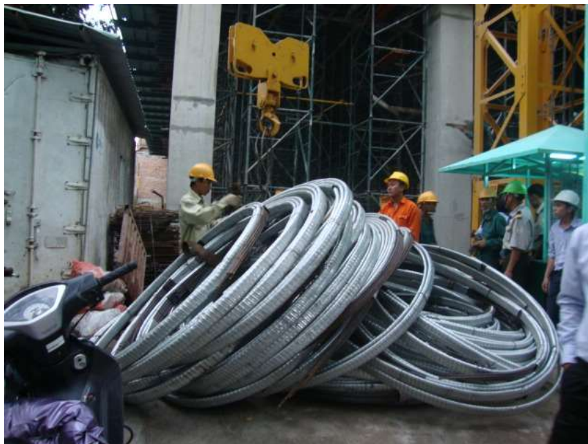
Cáp được gia công cắt và luồn vào ống cáp trước khi đưa vào lắp đặt
