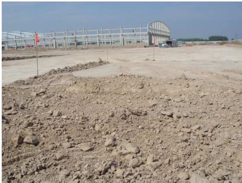
Tim tuyến đường được cắm mốc trên mặt bằng
