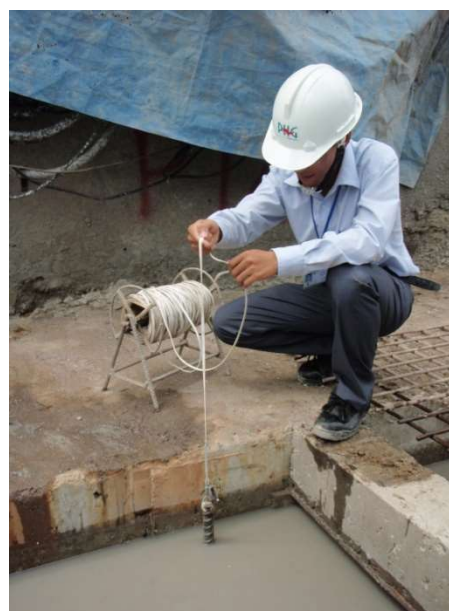
Dùng dây dọi kiểm tra độ sâu đáy hố đào
