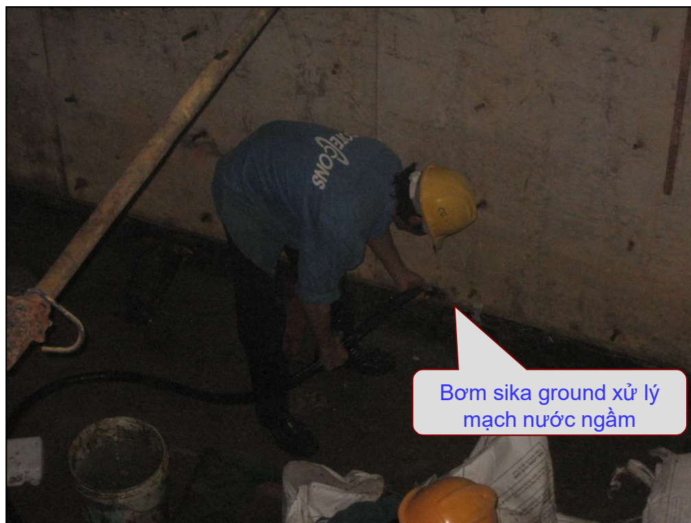
Xử lý mạch nước ngầm
