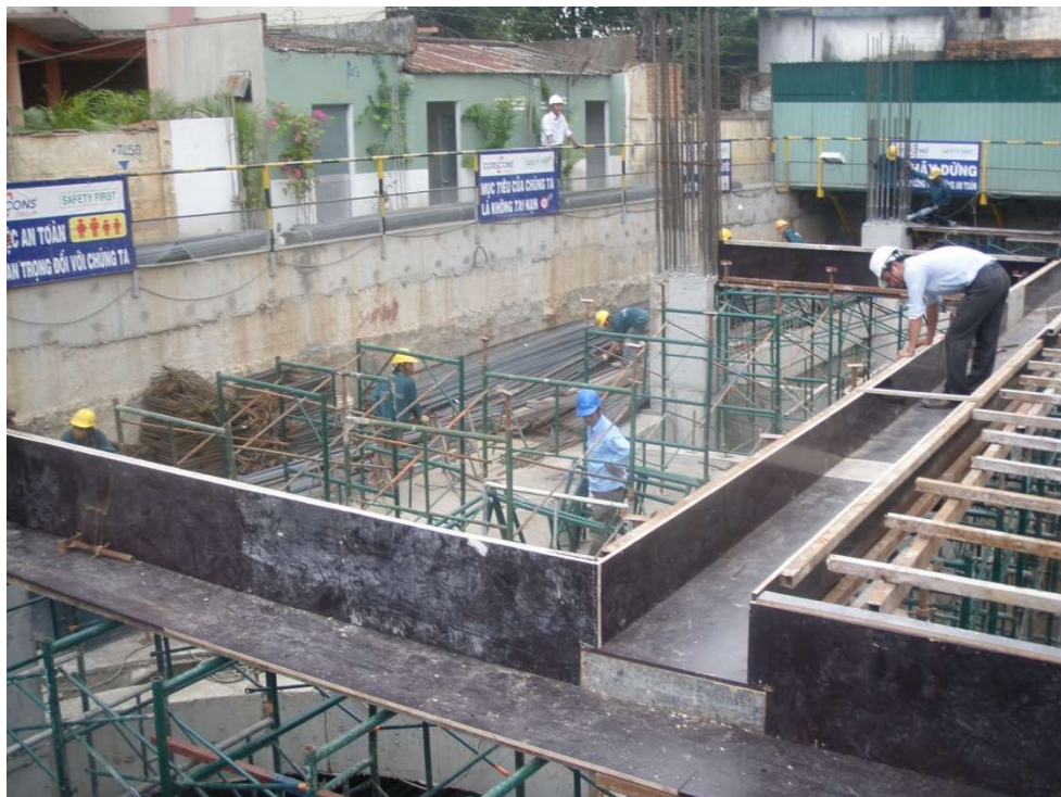
Lắp cốt pha thành dầm, lưu ý vị trí tiếp giáp giữa cốt pha đáy và cốt pha thành không có khe hở
