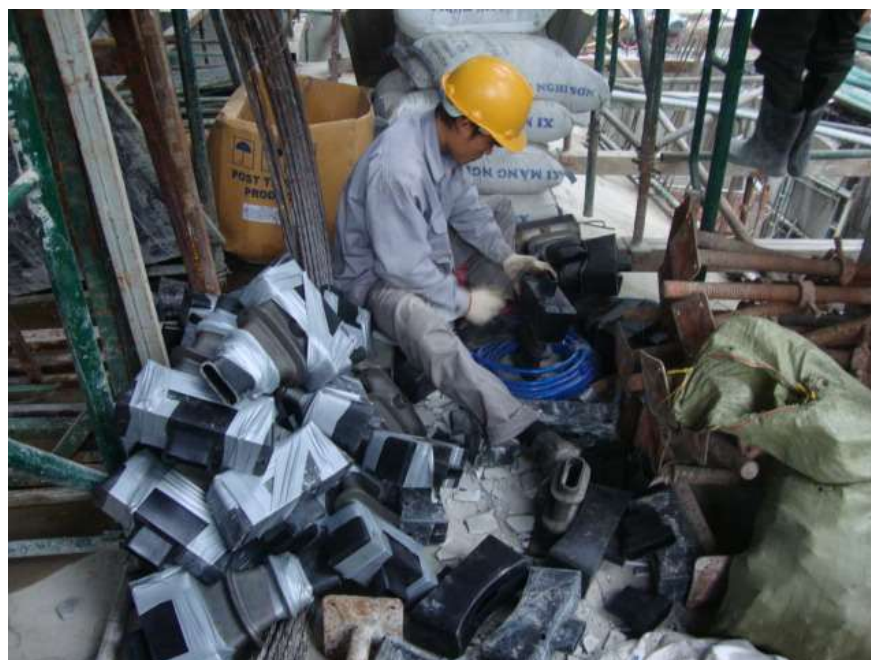
Gia công đầu neo sống
