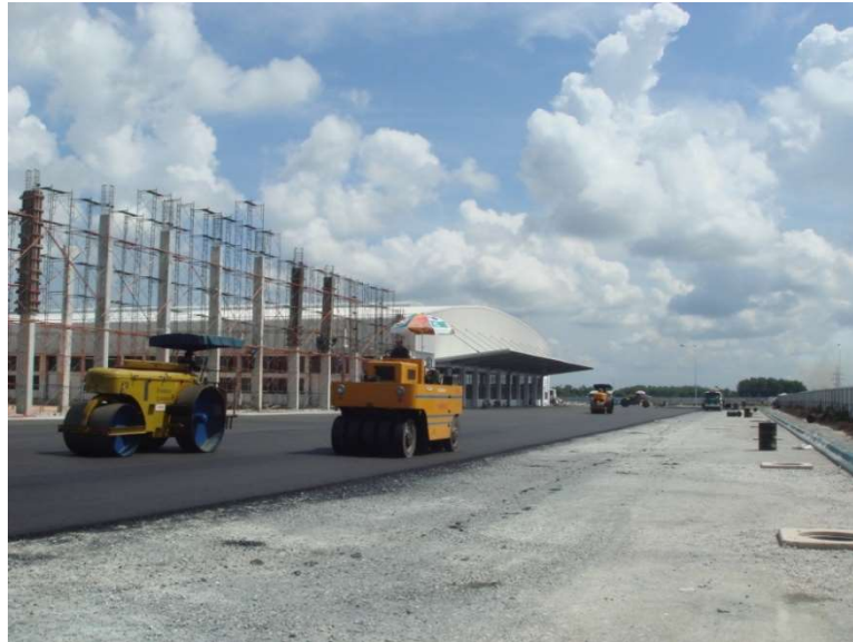
Thi công phun lớp nhũ tương và thảm lớp nhựa hạt thô
