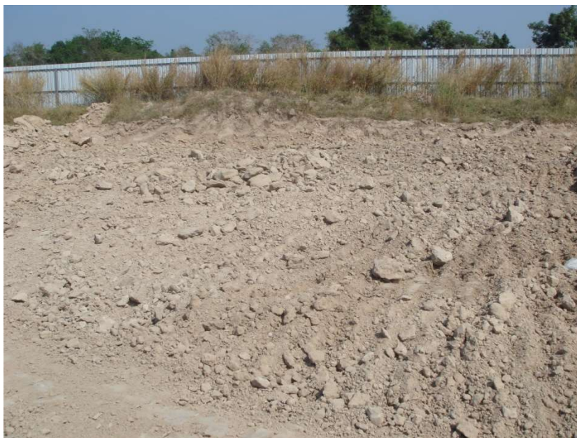
Tầng lớp đất hữu cơ, thực vật được bóc đi
