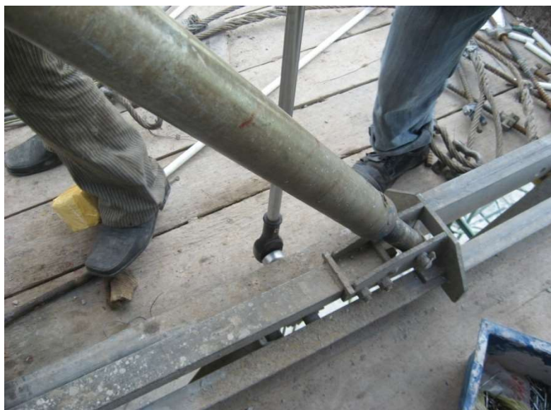
22. Tịnh tiến Copp pha vào vị trí tiếp xúc bề mặt vách
