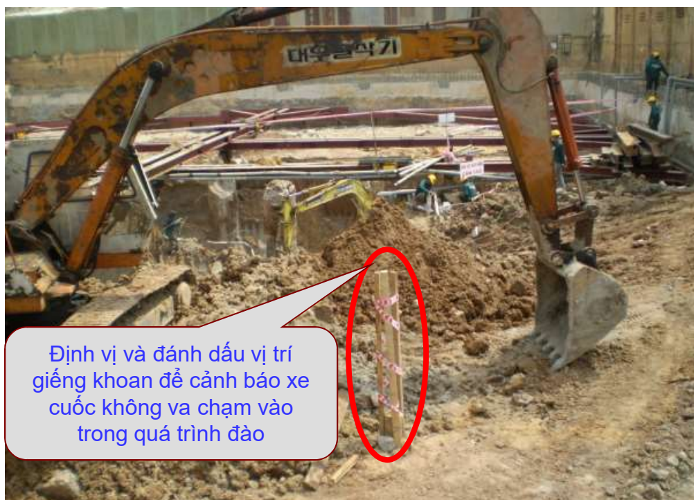
Đánh dấu vị trí giếng khoan trên mặt bằng đào đất
