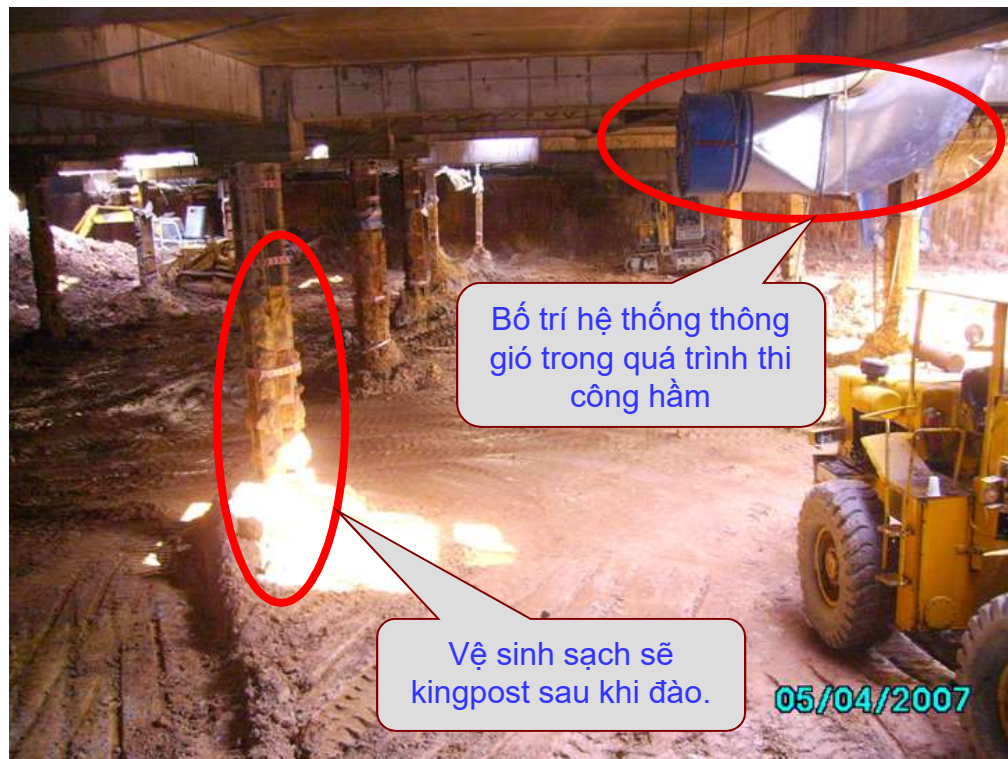
Vệ sinh và công tác thông gió khi thi công hầm
