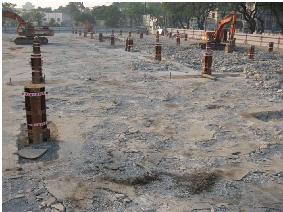
Dọn dẹp mặt bằng – đục nền bê tông
