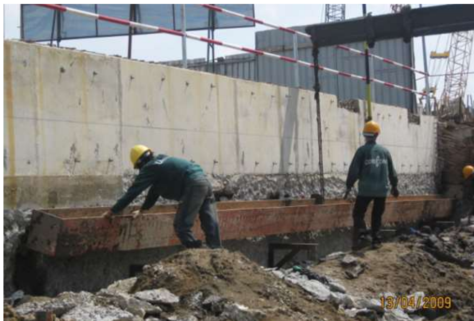
Lắp đặt hệ giằng biên
