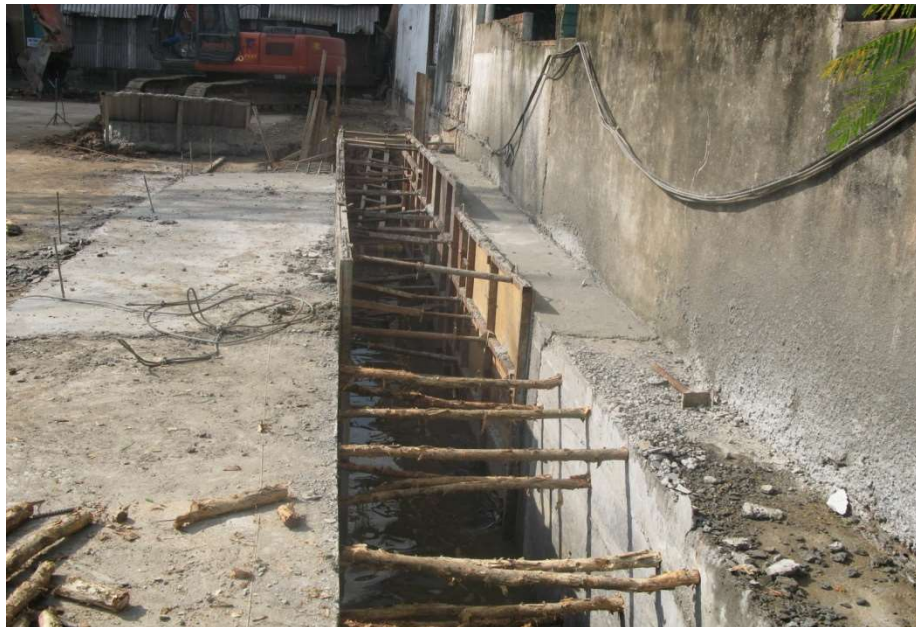
Chống văng ngang cho tường dẫn sau khi tháo cốt pha.
