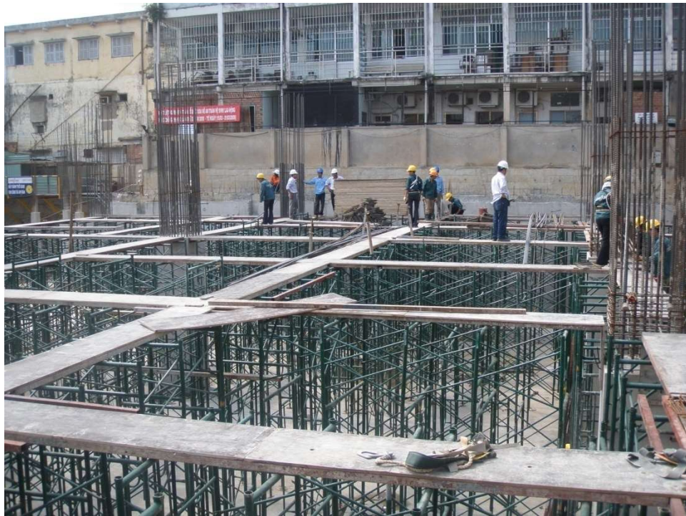
Lắp giàn giáo chống đỡ sàn theo bản vẽ shop-drawing được duyệt Lắp cốt pha đáy dầm
