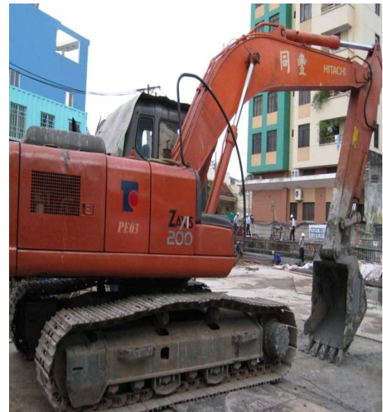
Máy đào đất
