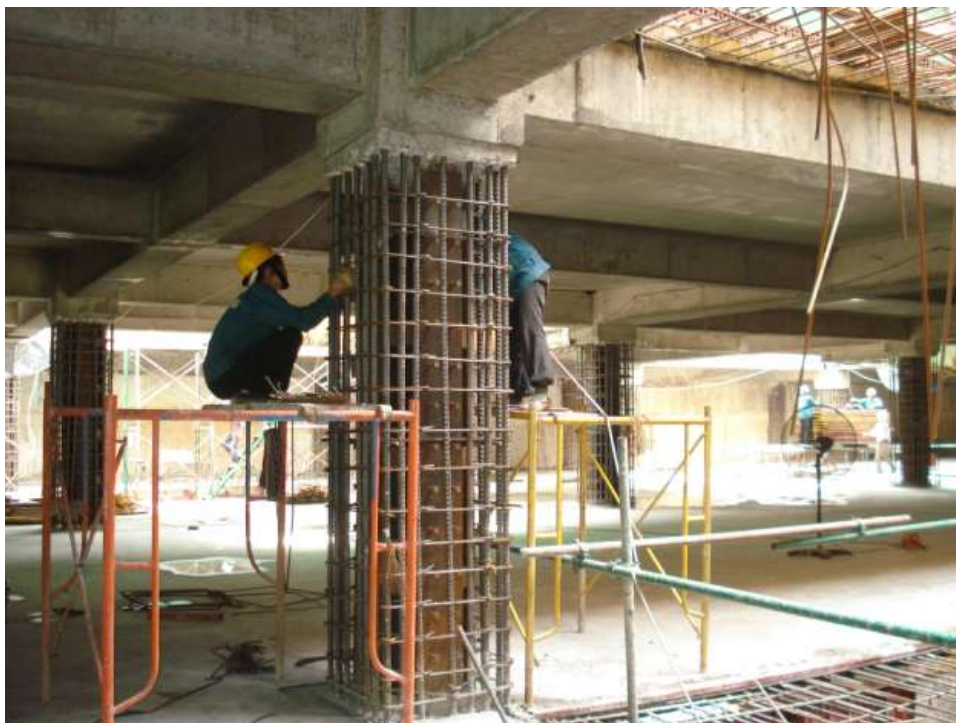
Lắp đặt cốt thép cột sàn hầm 1
