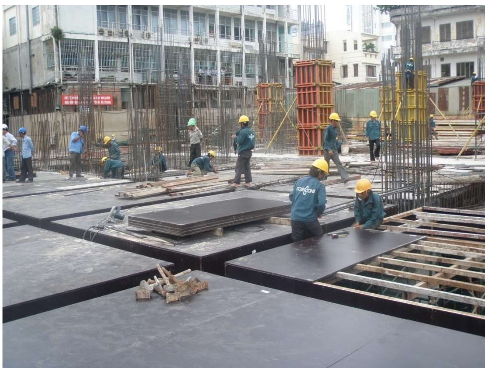
Lắp cốp pha sàn, lưu ý vị trí tiếp giáp giữa 2 tấm ván không được có khe hở
