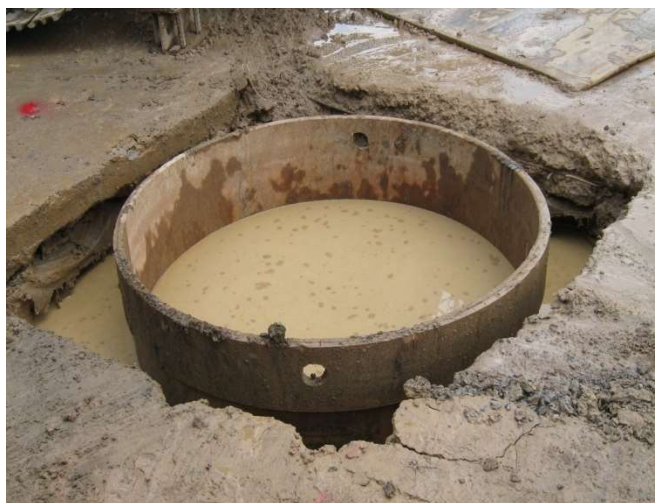
Ống vách được hạ vào vị trí cần khoan để bảo vệ hố đào.
