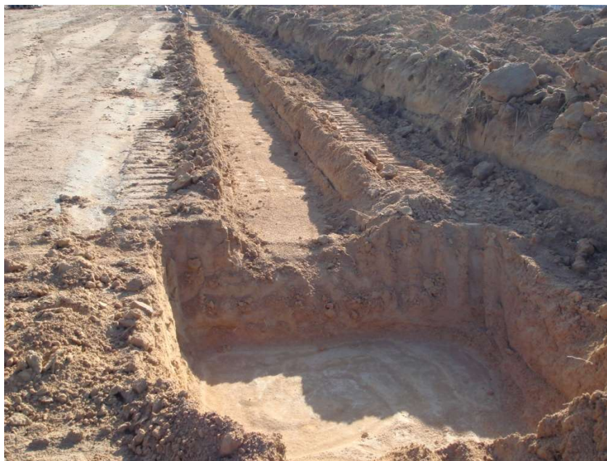
Đào đất đường cống và hố ga thoát nước đến cao độ thiết kế
