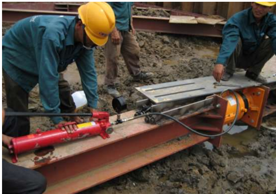
Lắp đặt hệ kích và bơm dầu
