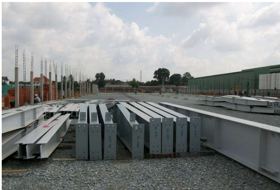
Tập kết kèo về công trường
