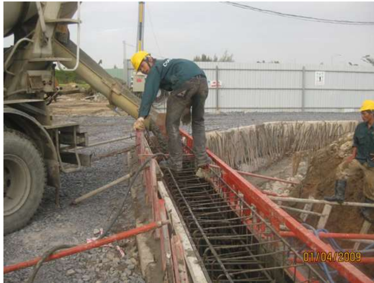
Thi công dầm giằng tường vây
