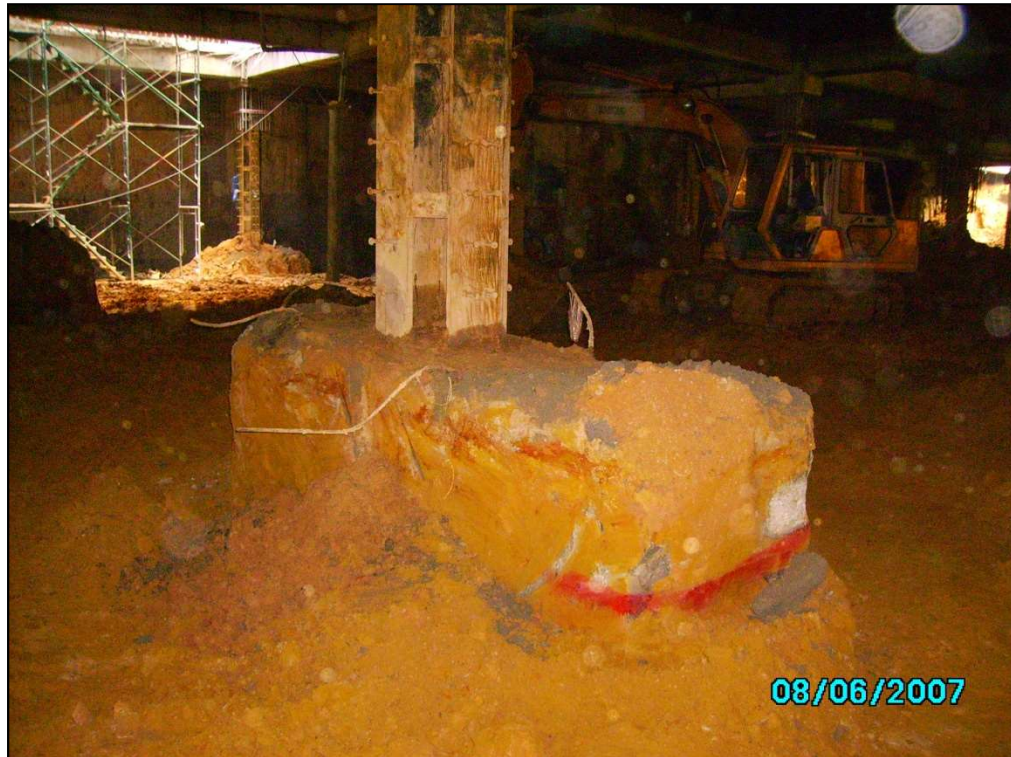
Đào đất và thi công móng, sàn hầm đáy của công trình
