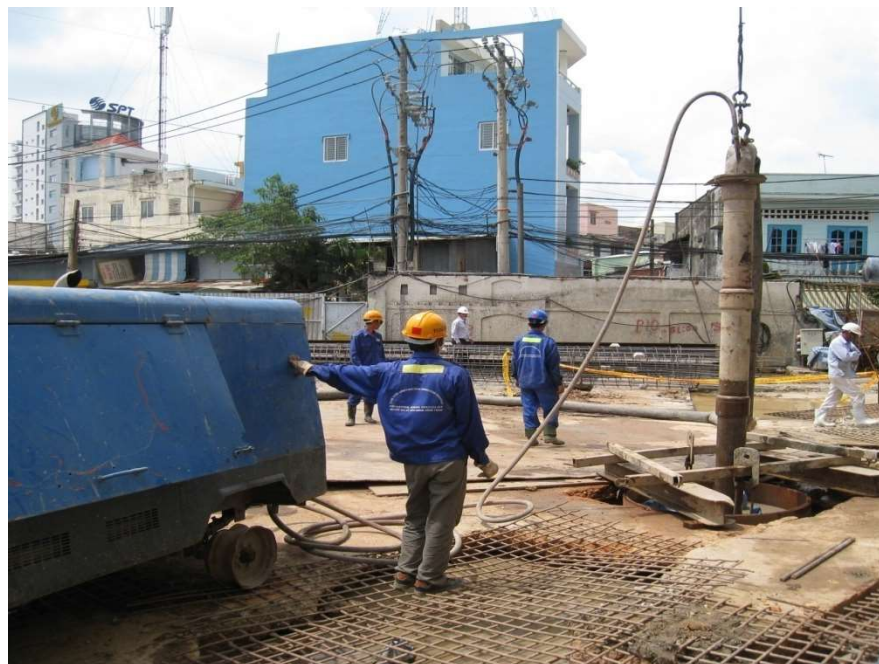
Thổi rửa đáy hố khoan ngay trước khi thực hiện công tác đổ bê tông
