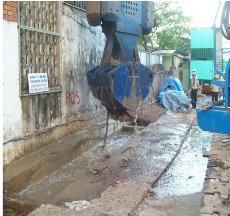
Quá trình đào đất.
