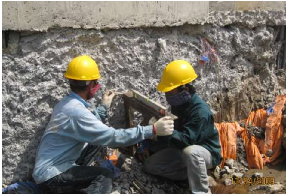
Khoan cấy lắp đặt hệ gối đỡ
