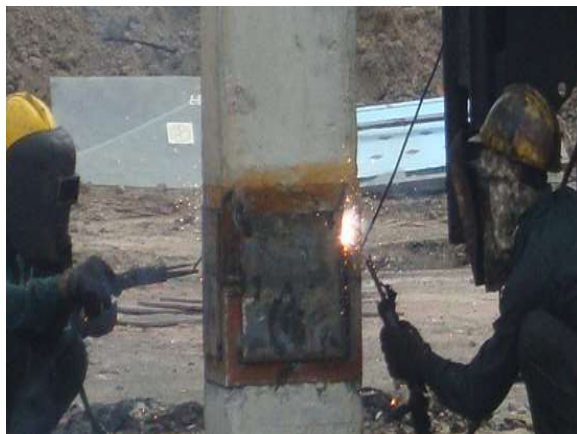
Nối cọc bằng bản mã
