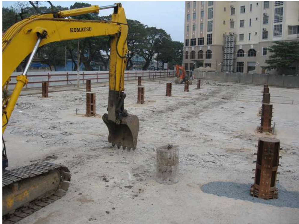
Mặt bằng tập kết máy móc thiết bị
