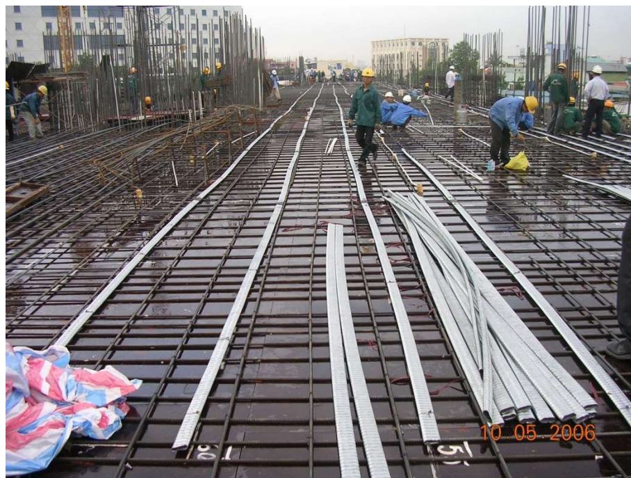
Mặt cốt pha phải được vệ sinh sạch sẽ trước khi tiến hành lắp đặt cáp
