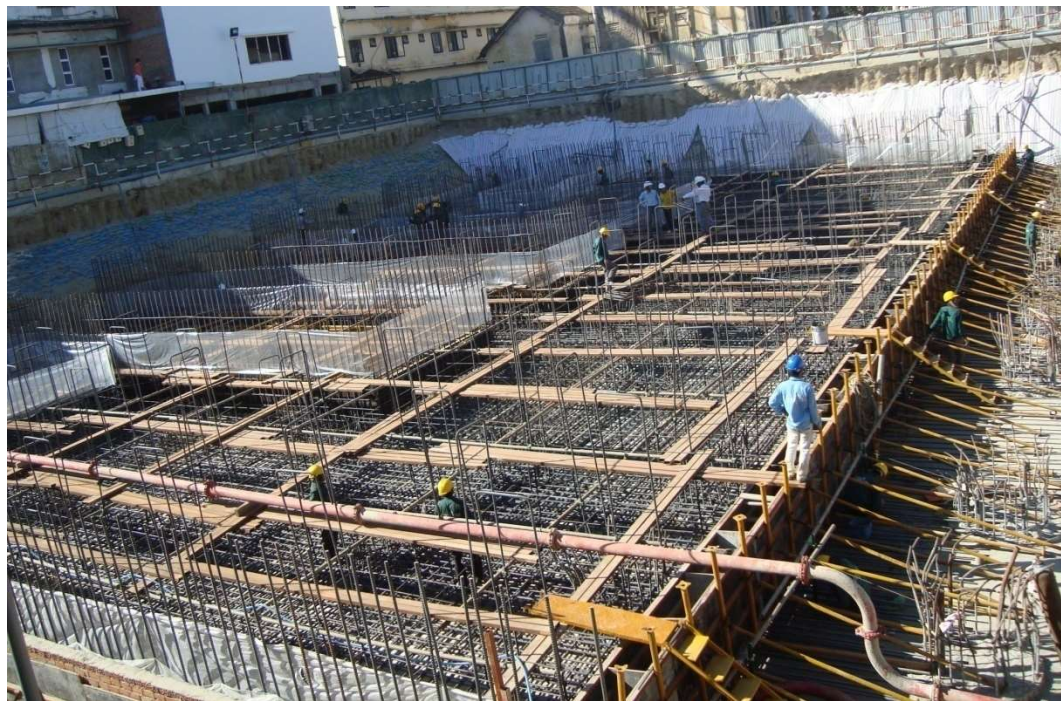
Hệ cốp pha móng tính toán & kiểm tra chắc chắn, bố trí sàn thao tác để đổ bê tông, quần ni lông hoặc bạt bảo vệ cốt thép
