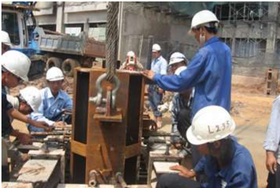
Lắp đặt hệ cột chống - kingpost
