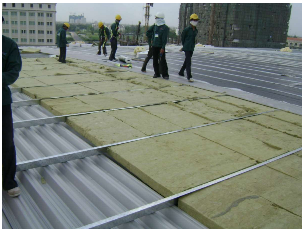
Thi công Rockwool
