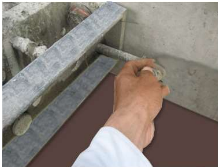
10. Tháo chốt an toàn vị trí ốc Doka trước khi cầu lên.
