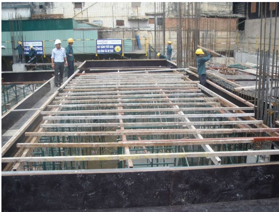
Lắp hệ xà gỗ (hệ pal) chống đỡ sàn thi công
