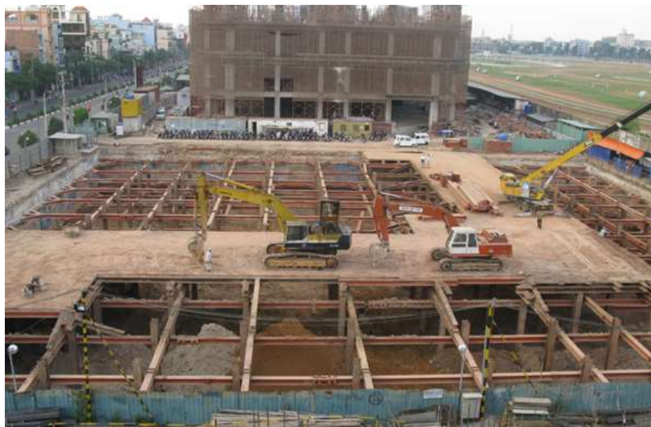
Làm hệ sàn thao tác cho xe đào và vận chuyển đất
