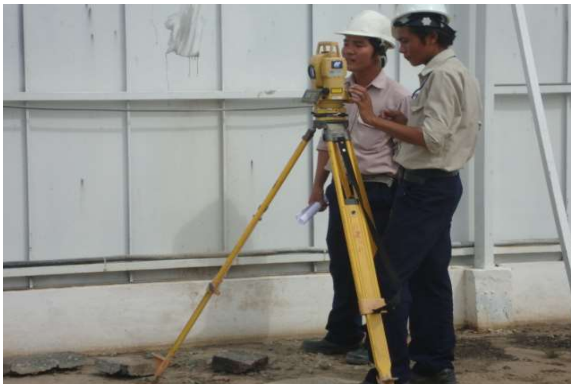
Sử dụng máy toàn đạc để xác định tim trục
