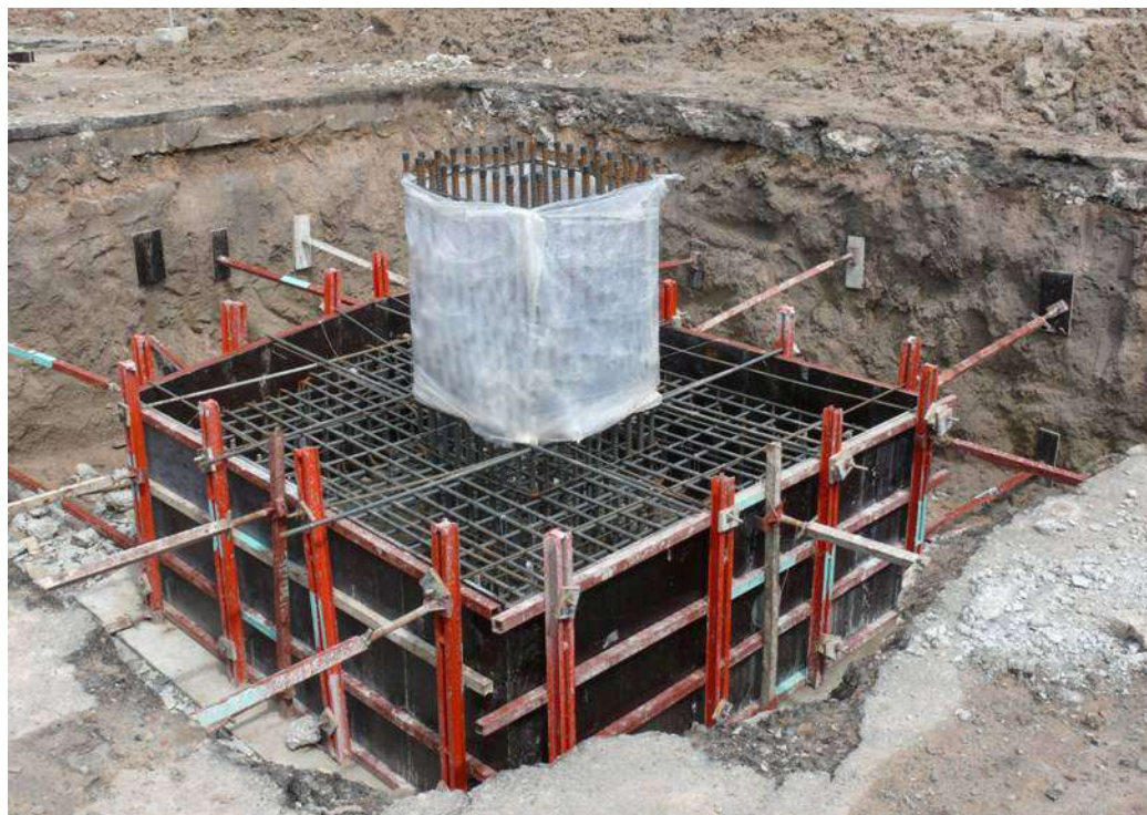
Quần ni lông (hoặc bạt) bảo vệ cốt thép cột, vách trước khi đổ bê tông
