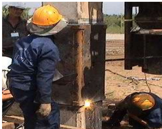
Nối cọc bằng hộp nối
