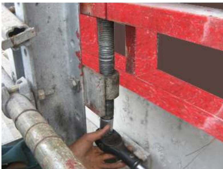
20. Điều chỉnh kích nâng hạ cấp pha.
