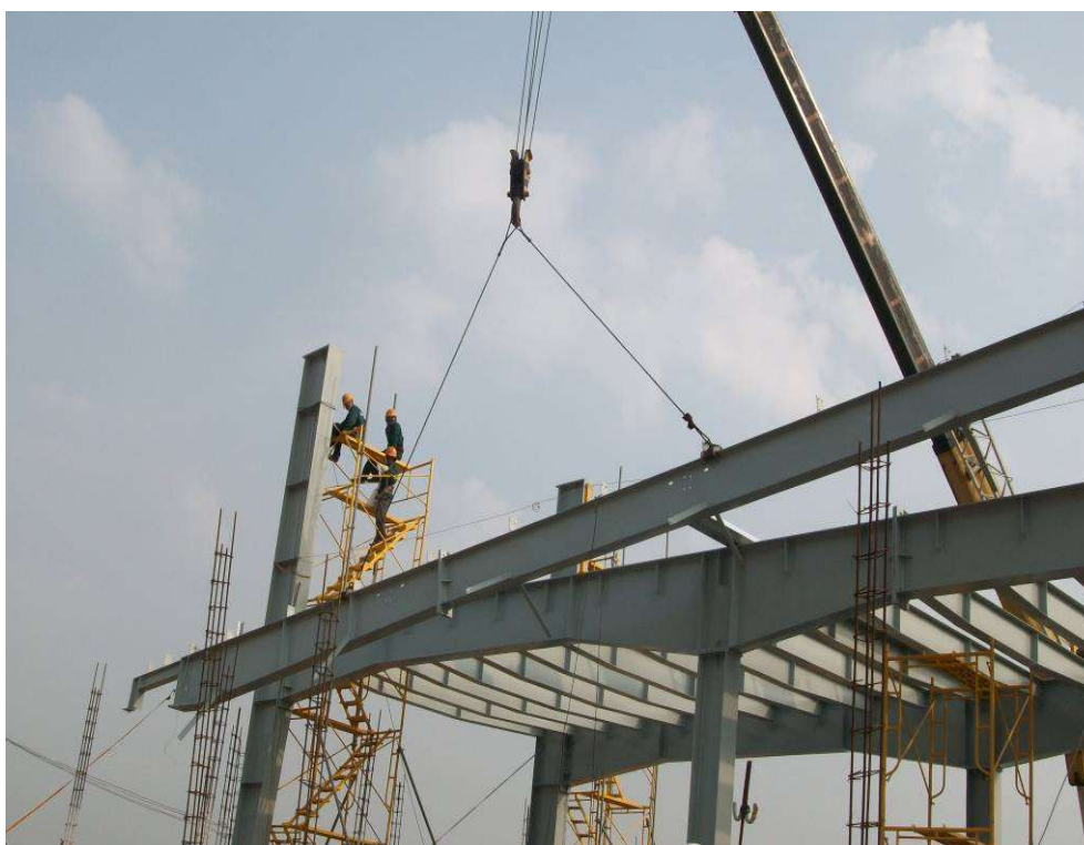
Lắp khung kèo lên cột
