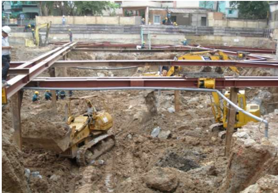
Dùng xe cuốc, xe xúc lật, xe ủi để vận chuyển đất
