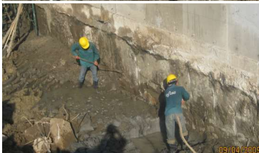
Vệ sinh bề mặt tường vây
