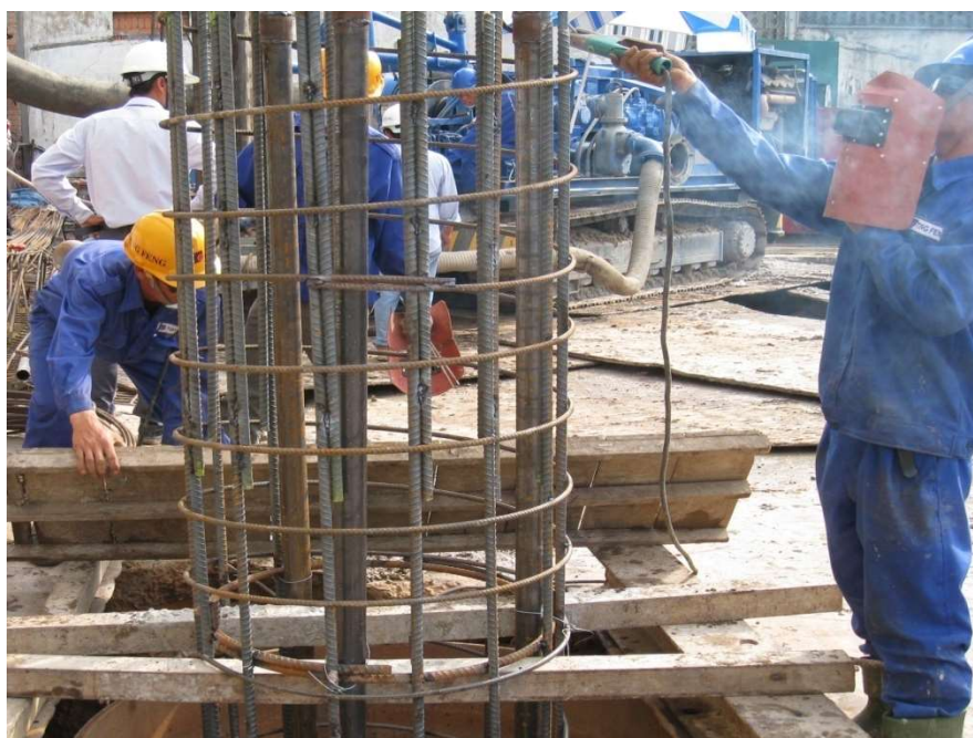
Cầu lắp lồng thép vào vị trí lỗ khoan
