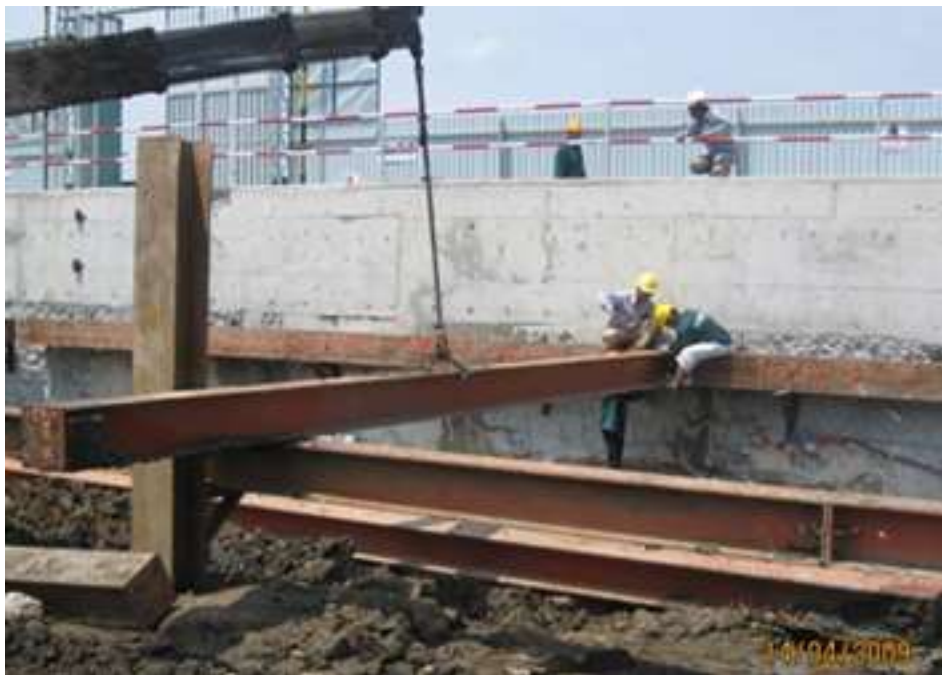
Lắp đặt hệ giằng chống ngang
