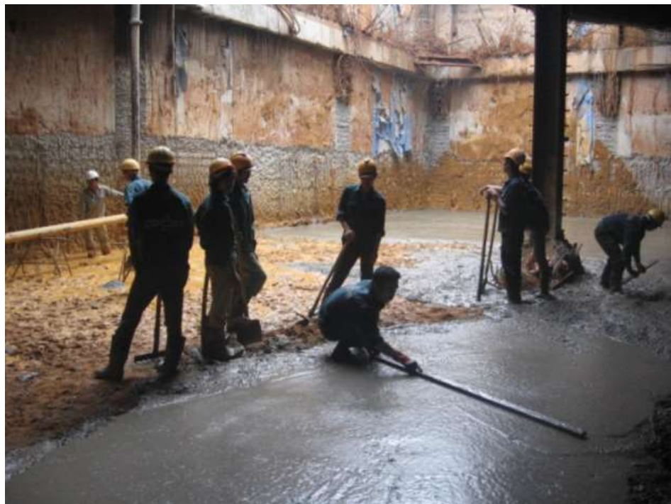
Bê tông lót cho sàn hầm 1
