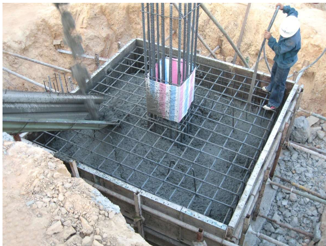
Lắp máng đổ bê tông
