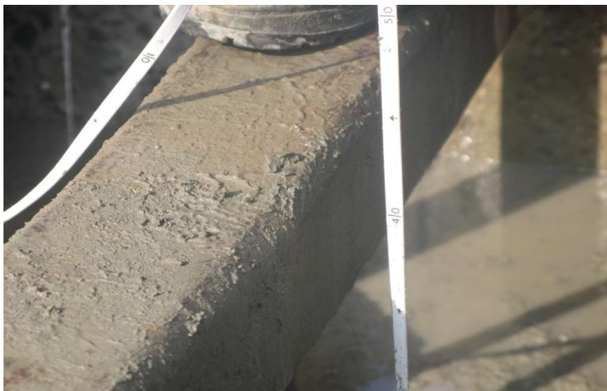
Dùng thước dây đo độ dãn bê tông
