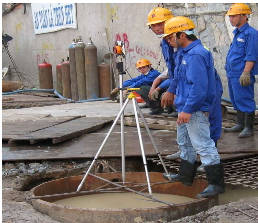
Kiểm tra nghiệm thu tọa độ ống vách bằng máy toàn đạc
