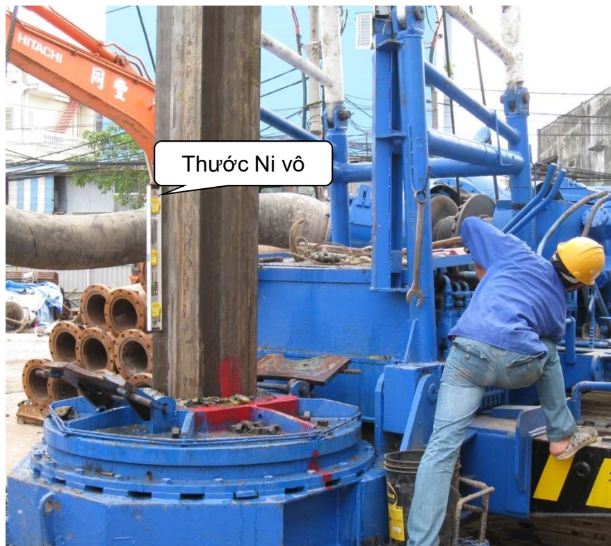
Cân chỉnh độ thẳng đứng của cần khoan bằng thước Ni vô (phương pháp khoan tuần hoàn nghịch).
