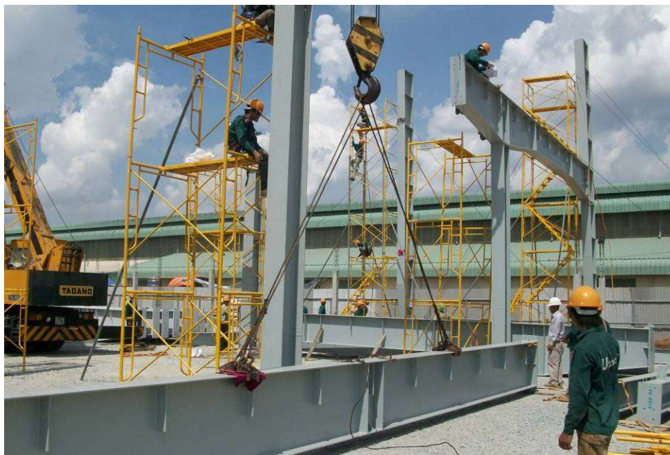
Lắp dựng cột và thanh giằng, cáp giằng tạm thành một hệ cứng tạm thời
