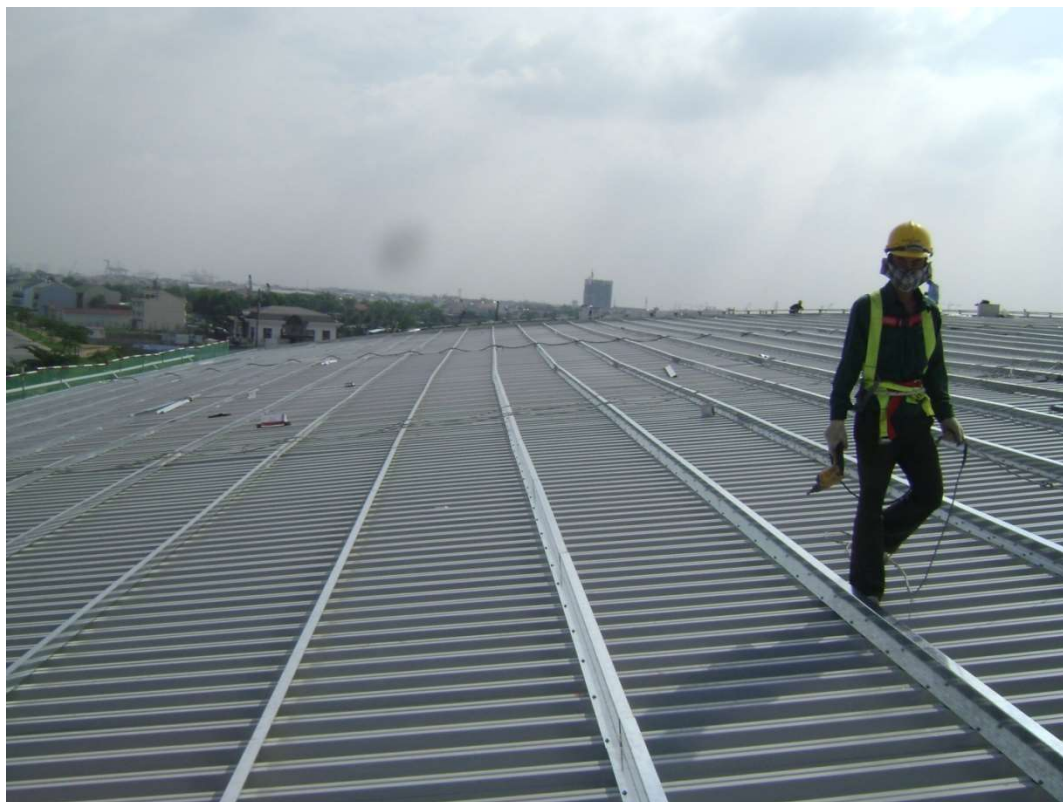
Lắp dựng xà gồ Z
