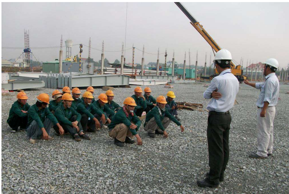
Kiểm tra sức khỏe và Nhắc nhở an toàn lao động công nhân hằng ngày trước khi lắp dựng
