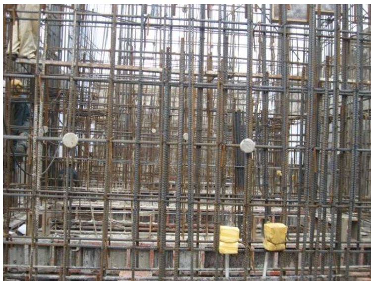
14. Nghiệm thu công tác cốt thép đã làm trước đó.
