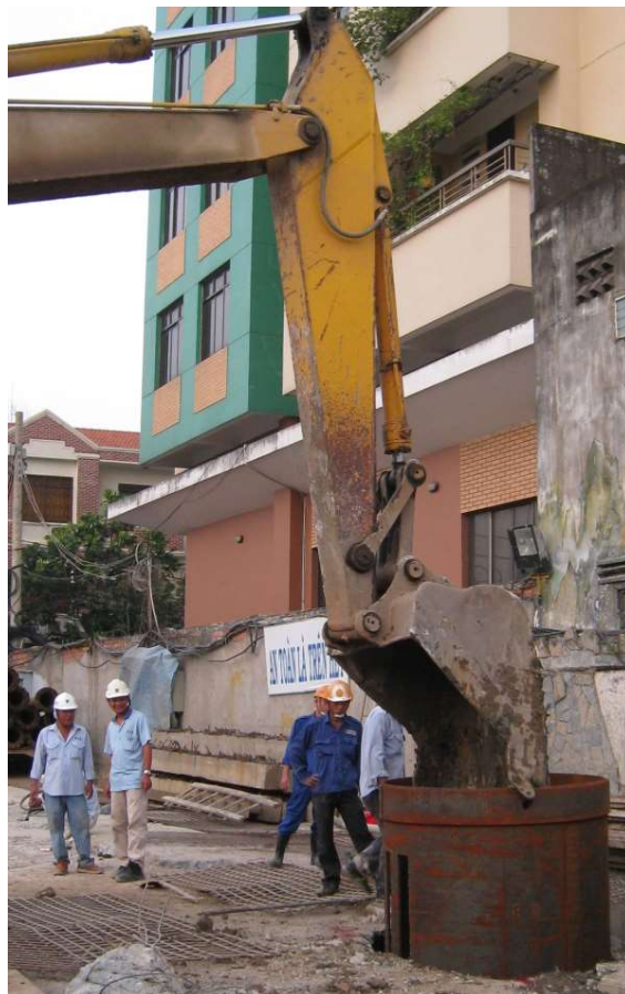
Sử dụng máy đào để hạ ống vách đến cao độ nền hiện hữu.
