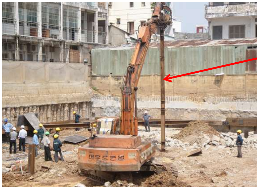
Không sử dụng cọc thép quá dài và mảnh để thi công trên nền đất tốt
