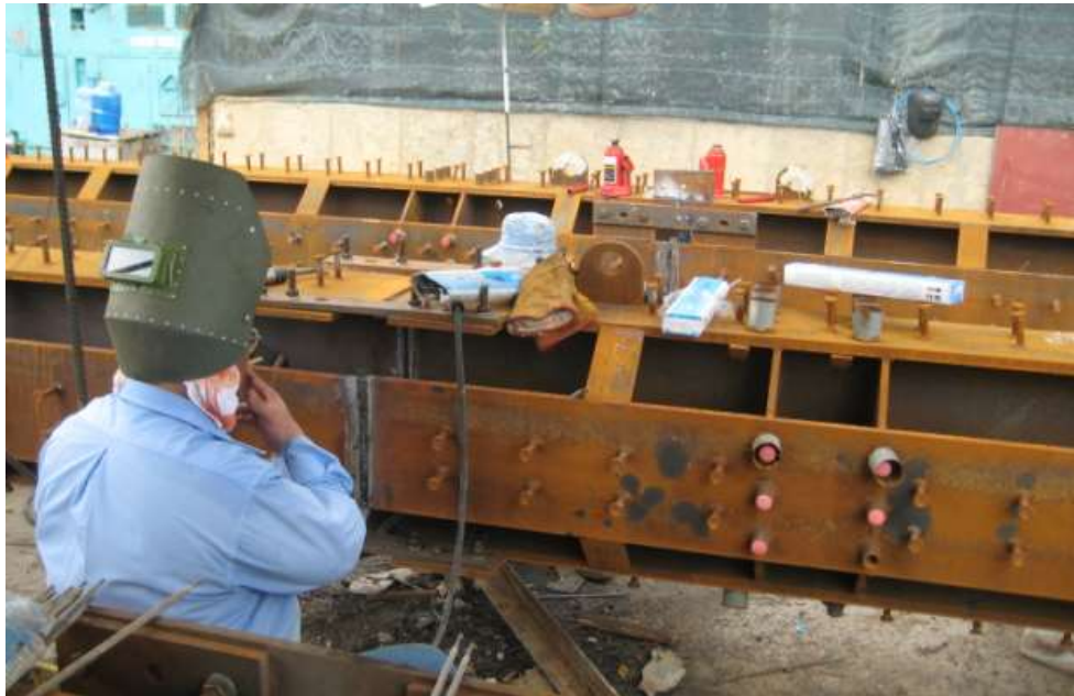
Gia công hệ cột chống - kingpost
