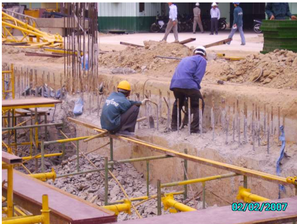
Đục bê tông đầu tường vây
