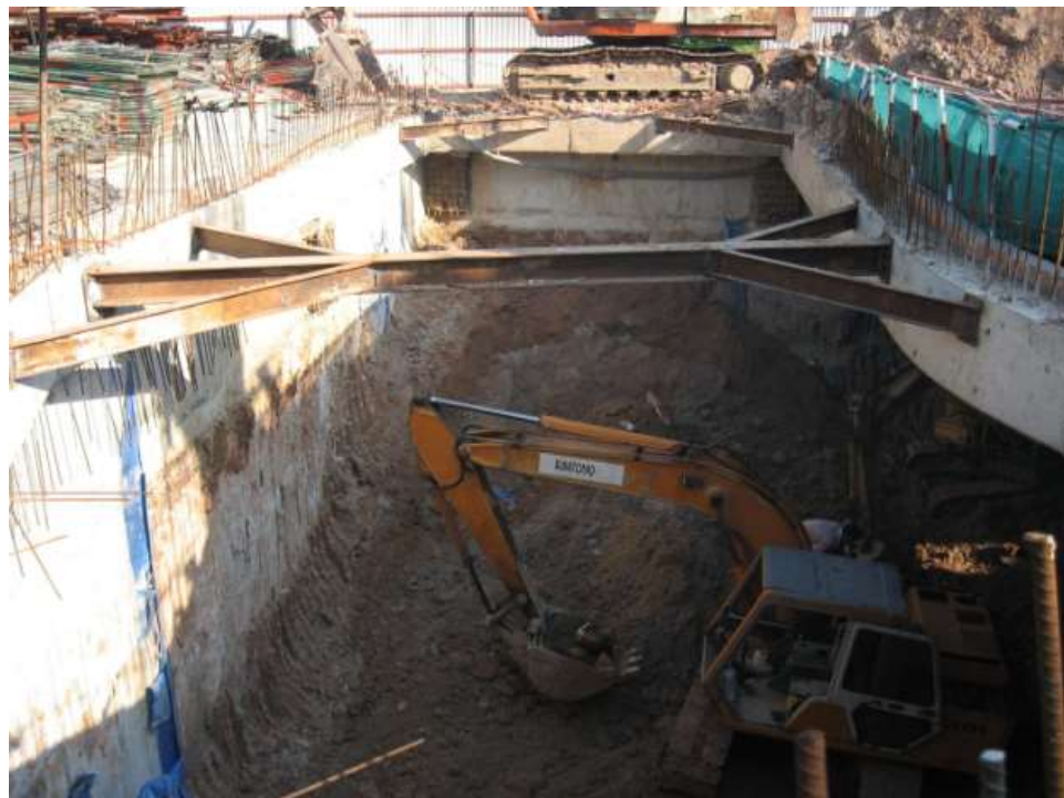
Chống đỡ, gia cố cho lỗ opening
