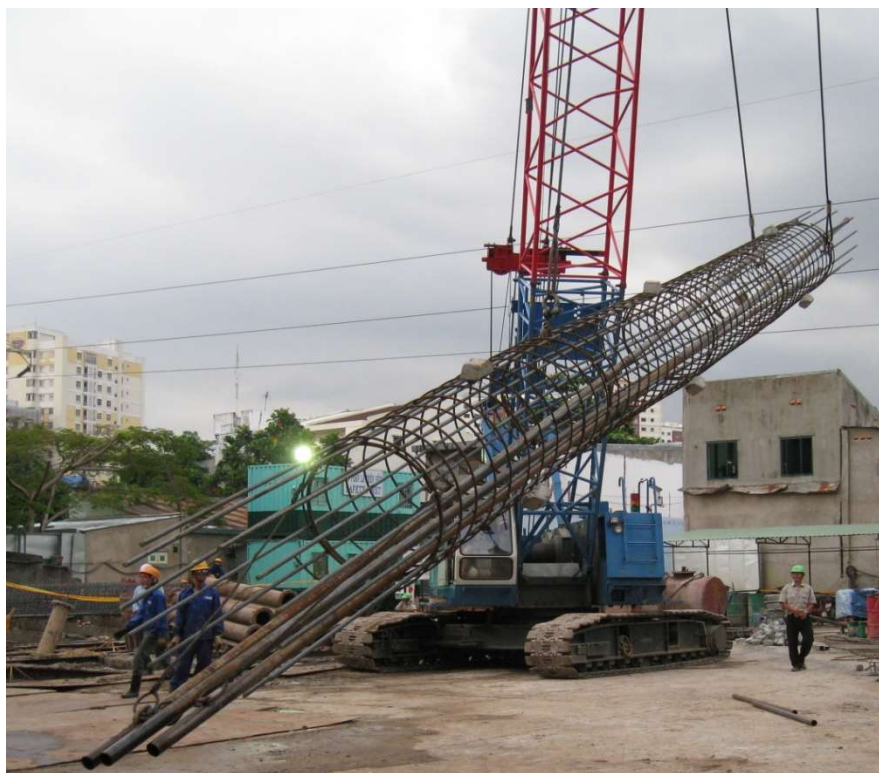
Cầu lắp lồng thép vào vị trí lỗ khoan
