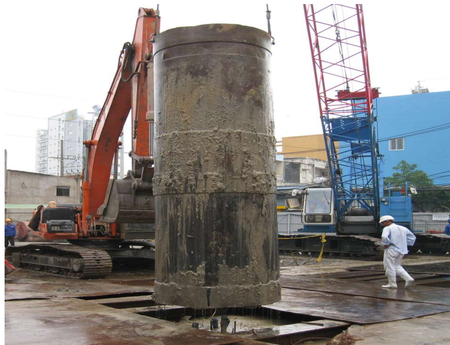
Rút ống vách sau khi đổ bê tông cọc
