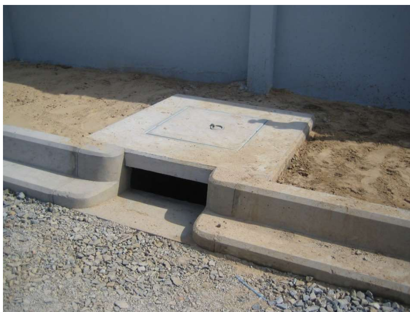
Hố ga sau khi thi công hoàn thành
