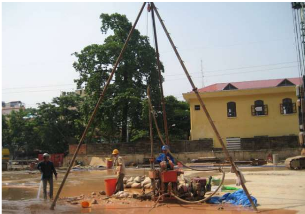
Khoan giếng hạ mực nước ngầm
