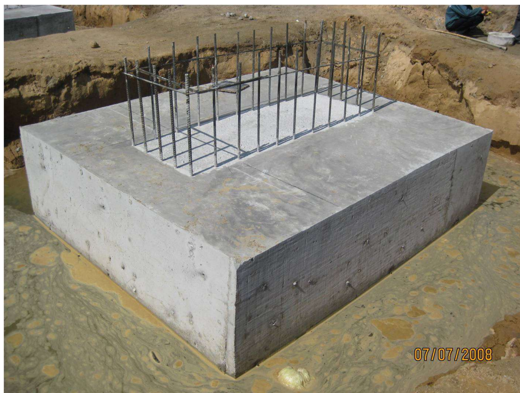
Trong quá trình đổ bê tông làm nhám mặt tại vị trí cột, vách
