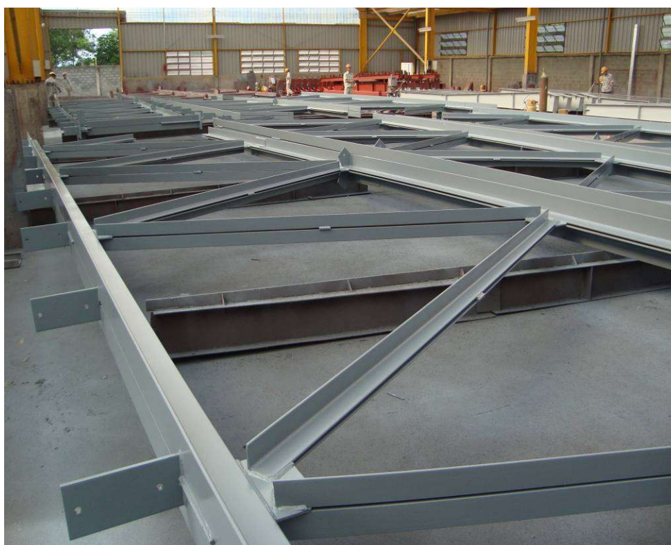
Công tác sơn hoàn thiện
