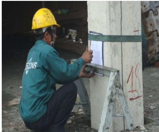
Công tác lấy độ chỗi cọc
