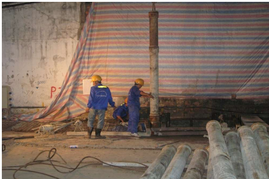
Lắp ống Trémie
