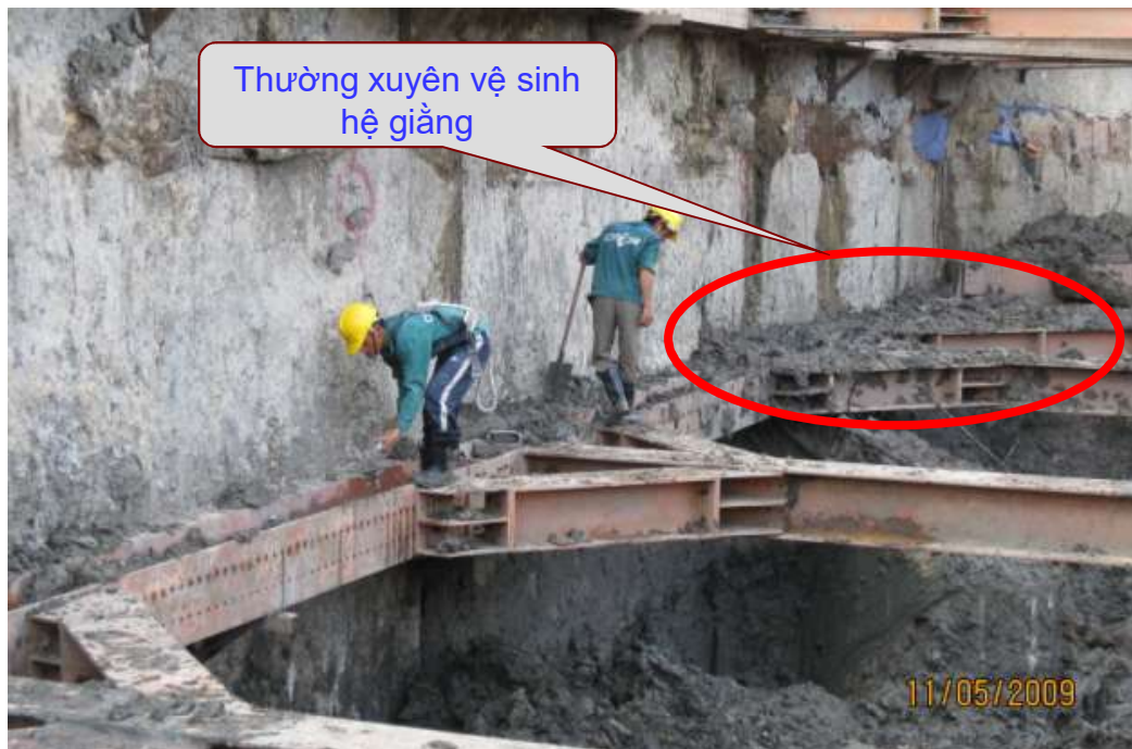
Đất đào chất đầy hệ chống ngang
