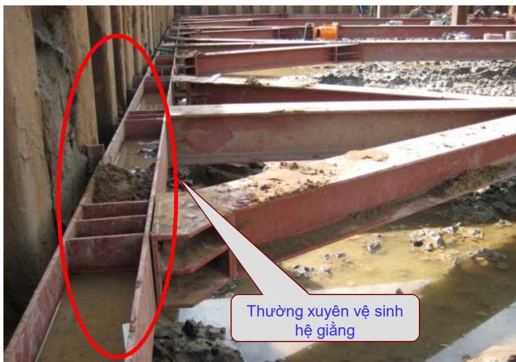
Nước và đất chứa đầy trong hệ giằng biên
