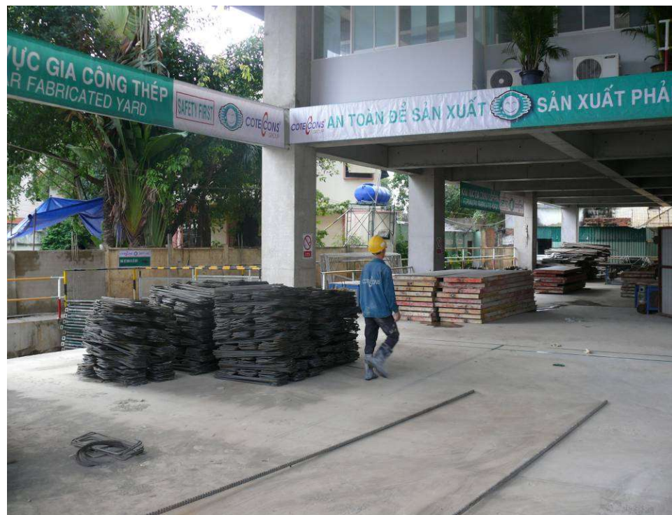
Công trình sạch sẽ, gọn gàng
