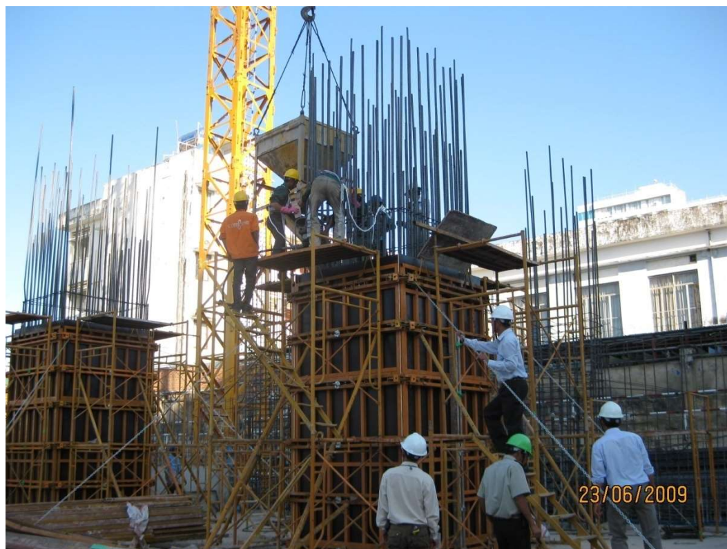
Dùng cầu tháp để đổ bê tông
