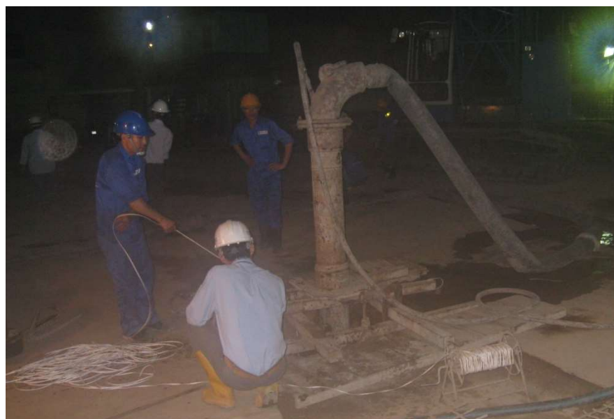
Kiểm tra cao độ đáy hố khoan sau khi thổi rửa bằng thước dây có gắn quả dọi.
