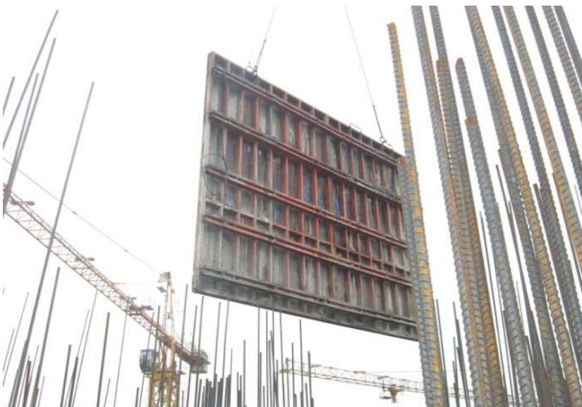
7. Tháo hệ cốt pha mặt trong
