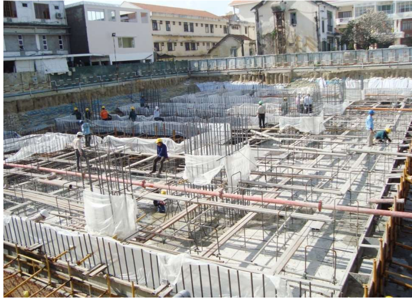
Hình ảnh không đặt thép chống nứt với chiều cao lớp đổ 1.2m
