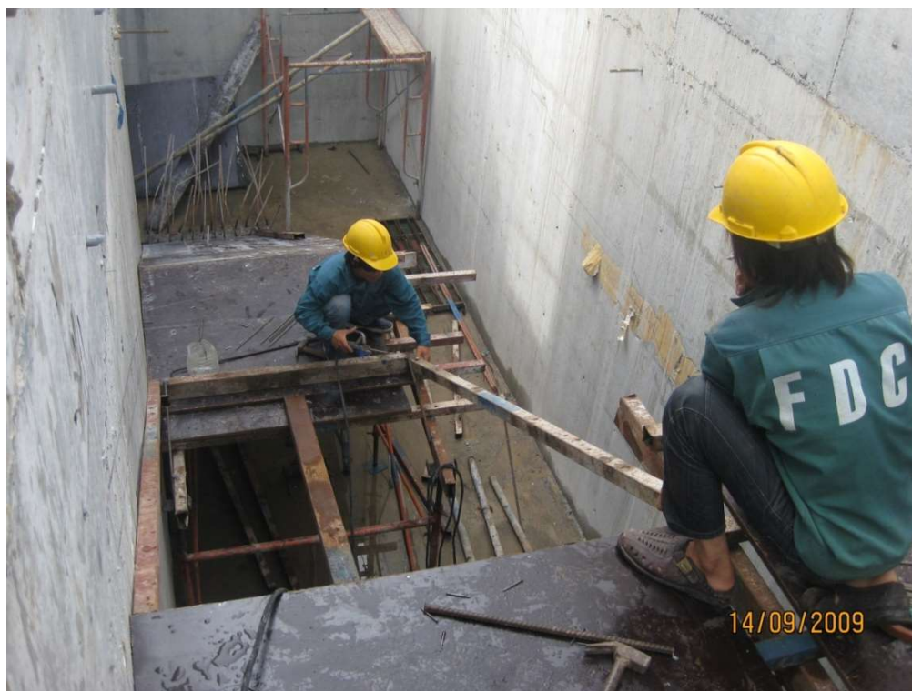
Gia công lắp dựng cốp pha, lưu ý kiểm tra kỹ cao độ
