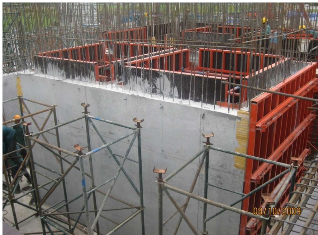
6. Công tác tháo cốp pha: được bắt đầu khi bê tông đạt cường độ cho phép, & vệ sinh sạch sẽ sau khi tháo.
