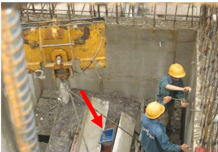
8. Tháo hộp Doka (dùng lắp hệ sàn tháo tác mặt trong)
