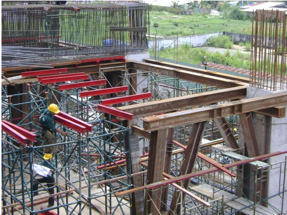
Chống đỡ bằng dầm I tại các lỗ thông tầng
