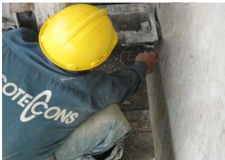
12. Lắp chốt an toàn trước khi tháo cầu neo sàn thao tác
