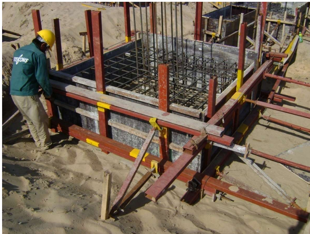
Hệ chống đỡ Copp pha được chống đỡ trên các cọc neo chắc chắn
