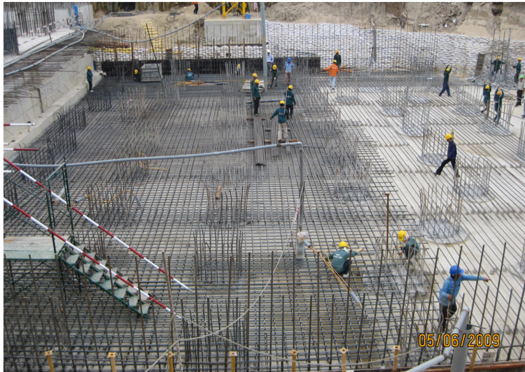
Bố trí mặt bằng thi công sạch sẽ, gọn gàng, lối lên xuống khu vực thi công an toàn
