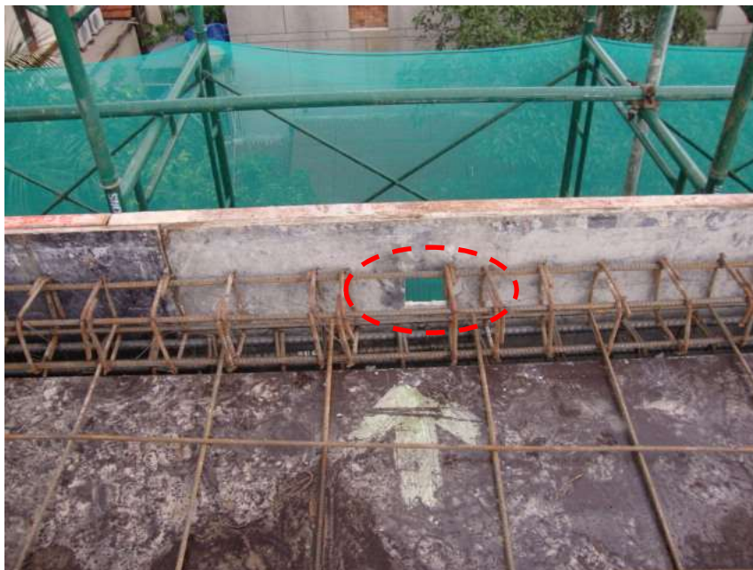
Khoan lỗ lên mặt cốtpha thành biên để lắp đầu neo sống
