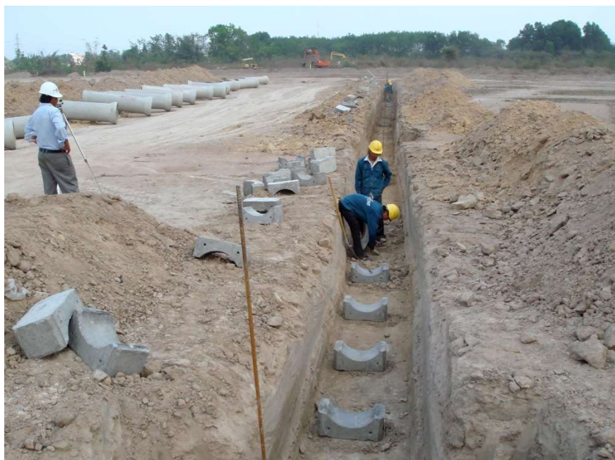
Lắp đặt gối cống, giám sát cần kiểm tra kỹ vị trí, cao độ của các gối cống
