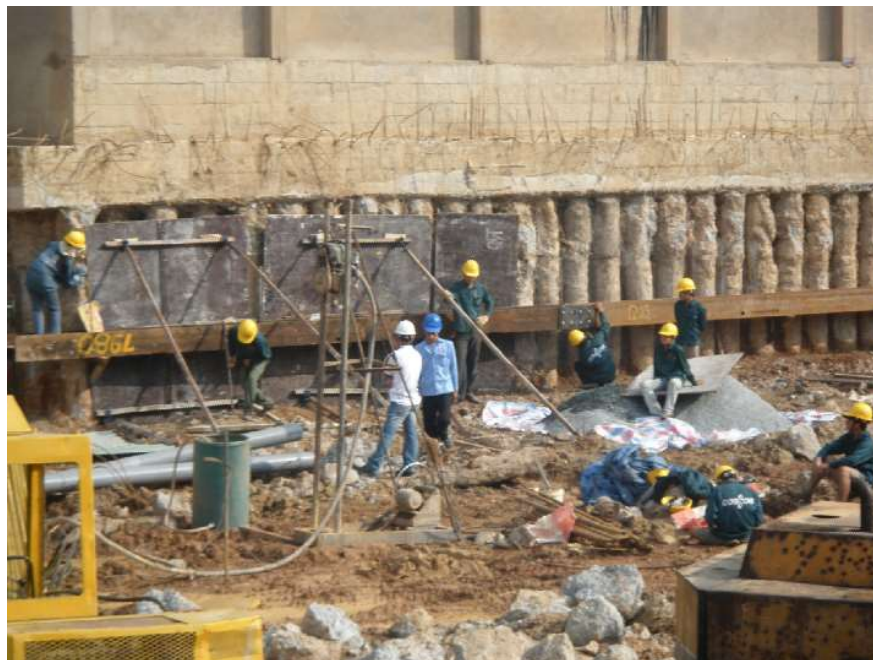
Khoan giếng hạ nước ngầm
