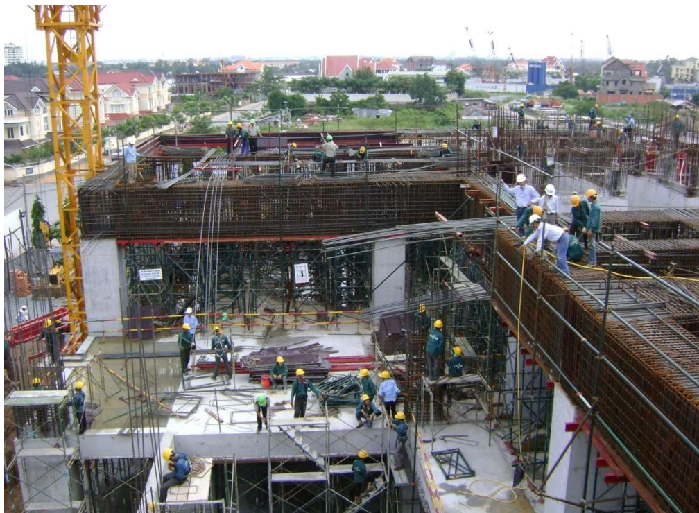
Chống gia cường ở các tầng bên dưới bằng giàn giáo pal loại trung bình
