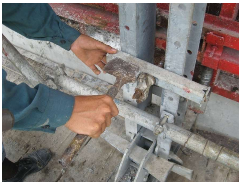
21. Siết ty khóa chân cấp pha sau khi đã điều chỉnh đúng vị trí. (Lưu ý kiểm tra kỹ các cỡ nằm trong cấp pha trước khi siết ty)
