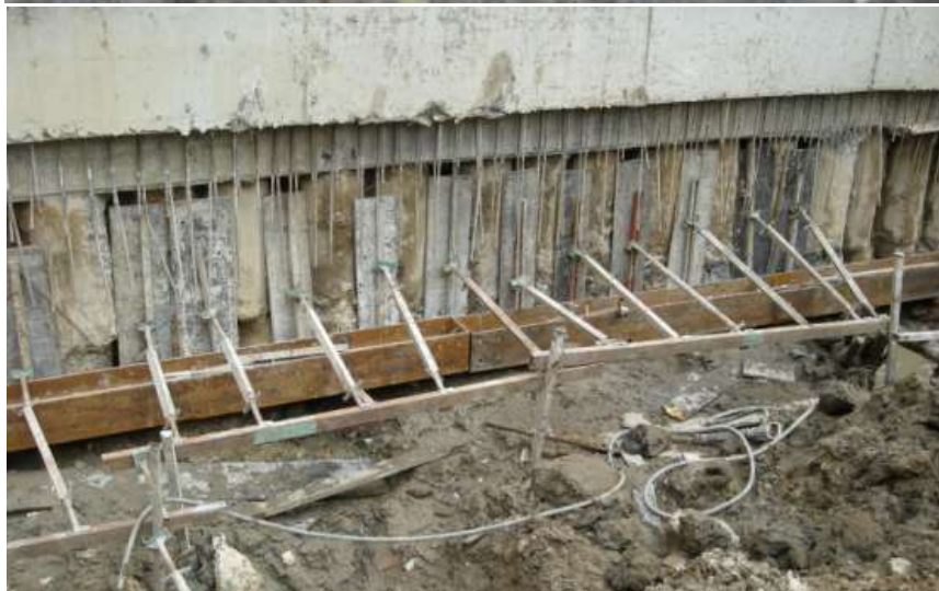
Đổ bê tông chèn cọc vây
