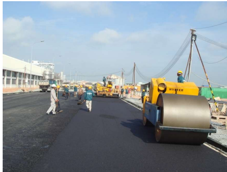
Thi công thảm lớp nhựa hạt mịn
