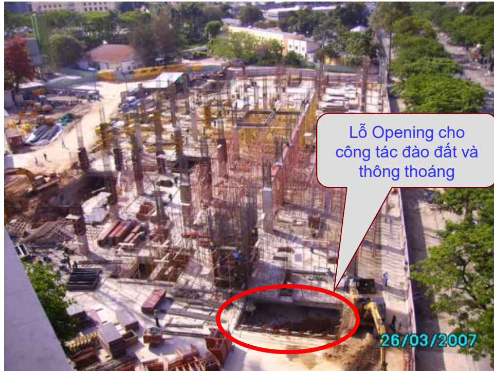
Bố trí lỗ opening trên mặt bằng trệt
