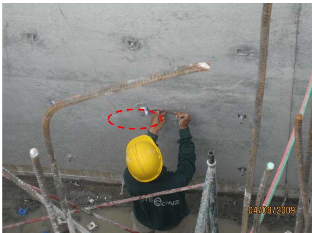
8. Đục, trám lỗ ty đối với các vách nằm ở mặt ngoài công trình, hồ thang máy
