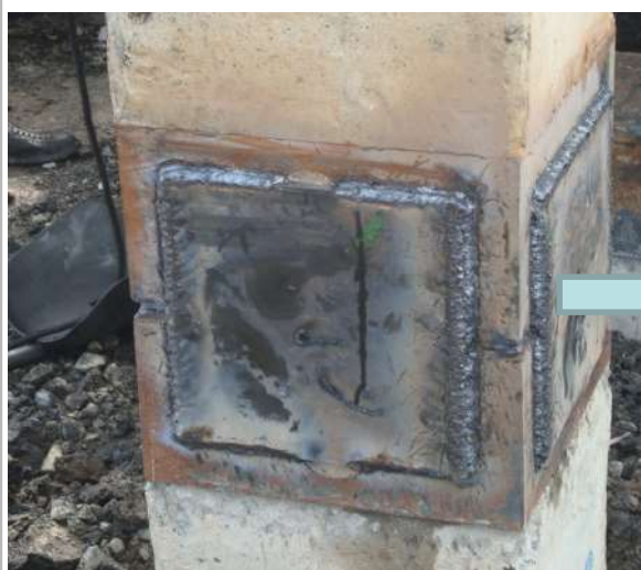
Kiểm tra chất lượng đường hàn
