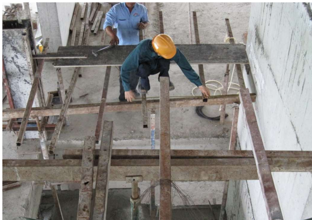
Lắp dựng giàn giáo và hệ chống đỡ cầu thang
