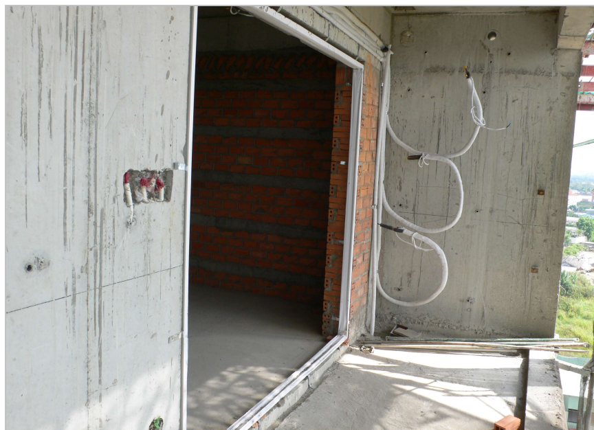
Cán lớp vữa bảo vệ màng chống thấm cho lô gia.
