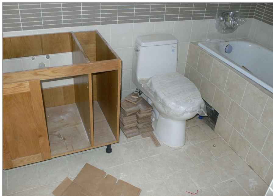
Lắp kệ la-va bô.
