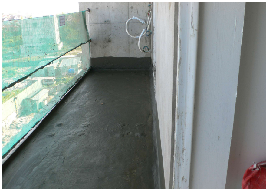
Quét màng chống thấm sàn lô gia.
