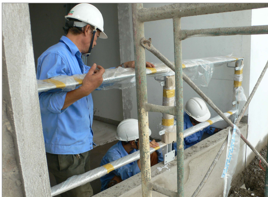
Lắp đặt ban công.
