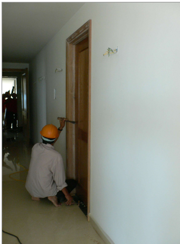
Căn chỉnh lắp đặt cửa gỗ.
