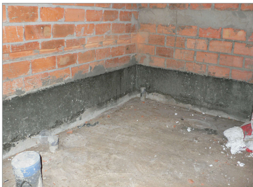
Cán lớp vữa bảo vệ màng chống thấm trong phòng vệ sinh.
