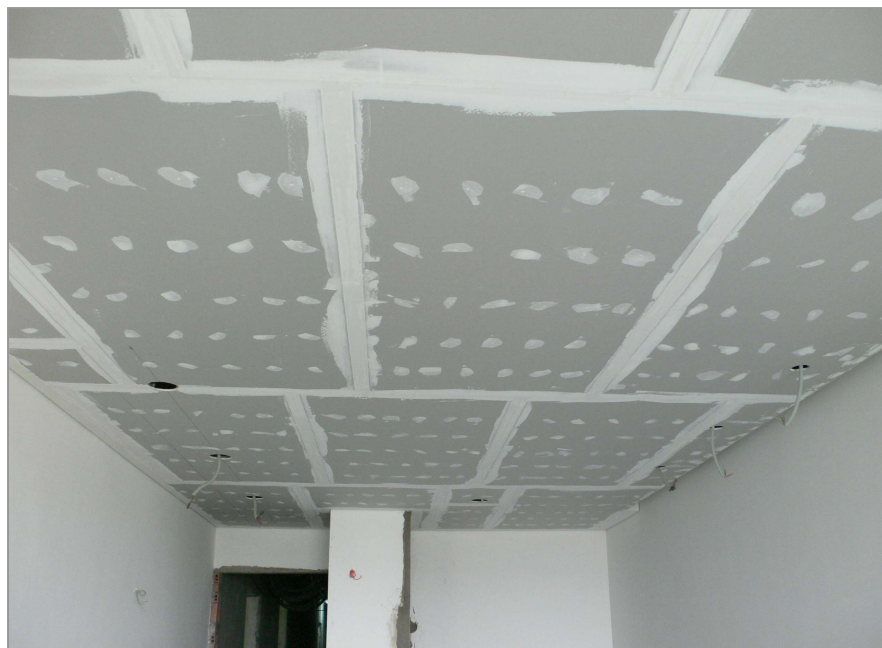
Trần sau khi dán băng keo lưới chống nứt.
