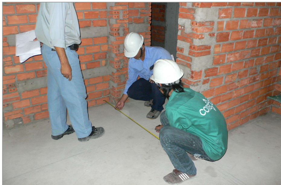
Tiến hành kiểm tra nghiệm thu tường xây theo thiết kế.
