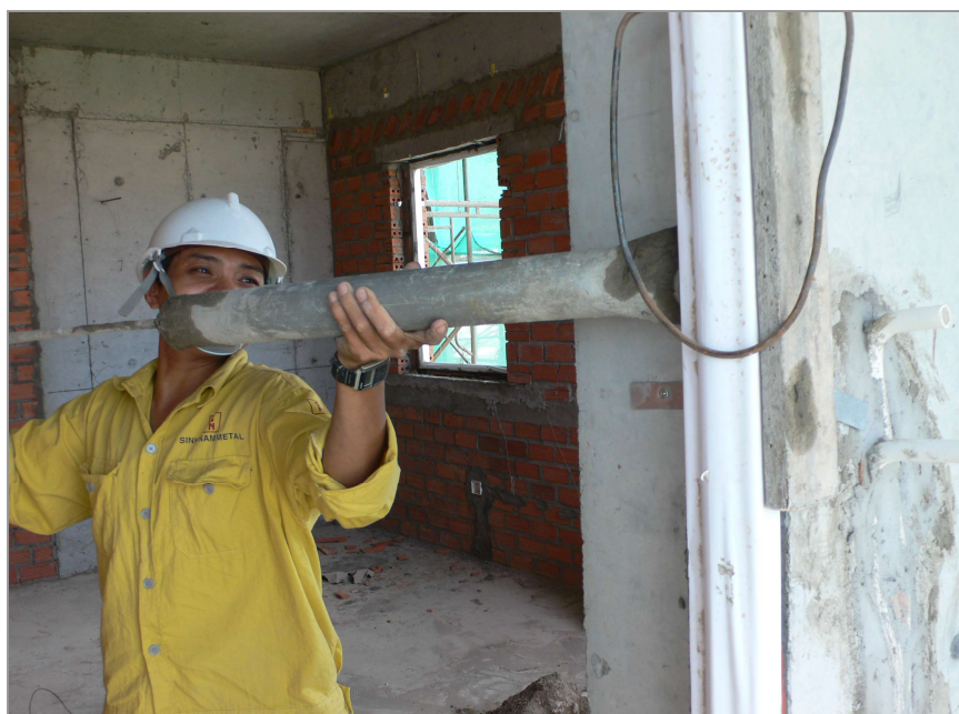
Bơm vữa chèn khe giữa khung cửa với tường.
