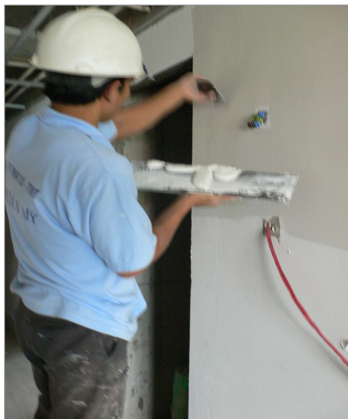
Khi lớp lót 1 đã khô, bả tiếp lớp lót 2. Lớp 2 khô tiến hành xoa phẳng mặt. Các lớp bả có độ dày không lớn hơn 1mm.
