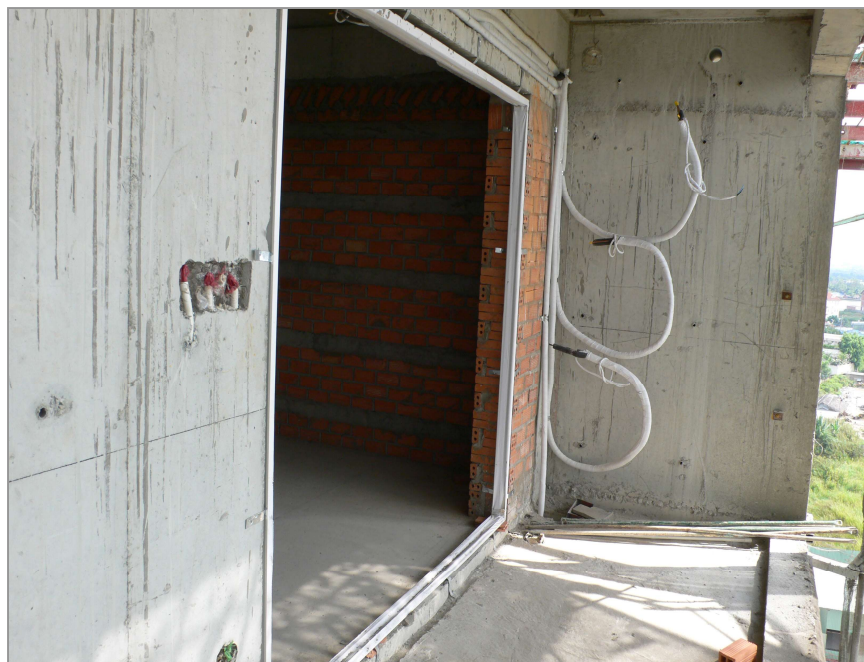
Lắp dựng khung cửa đi.
