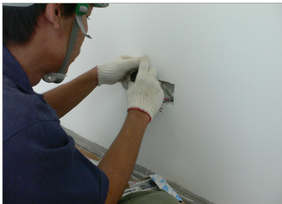
Lắp mặt nạ ổ cắm điện. Phải có bao tay khi thao tác để bảo vệ tường sạch sẽ.
