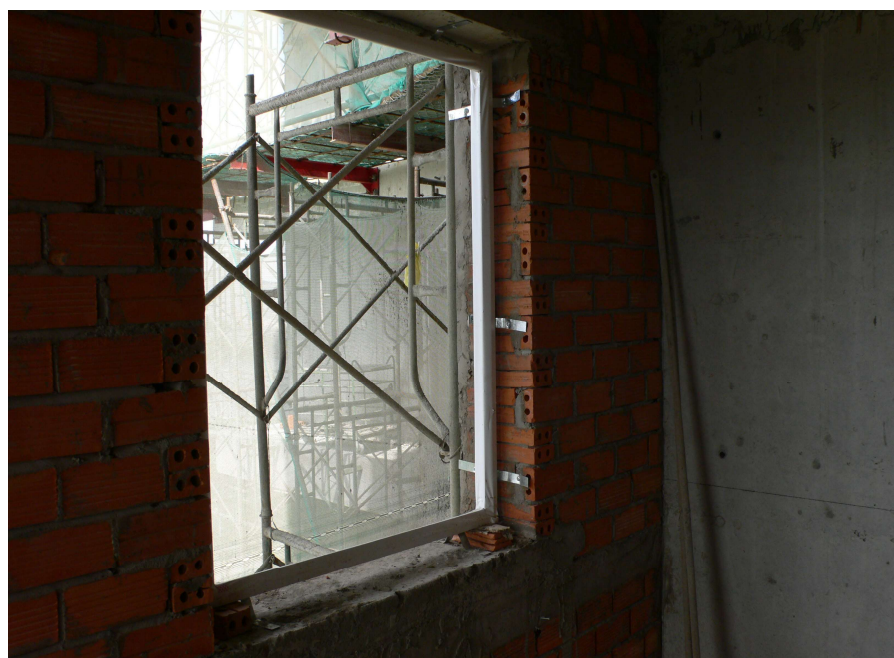
Lắp khung nhôm cửa sổ.
