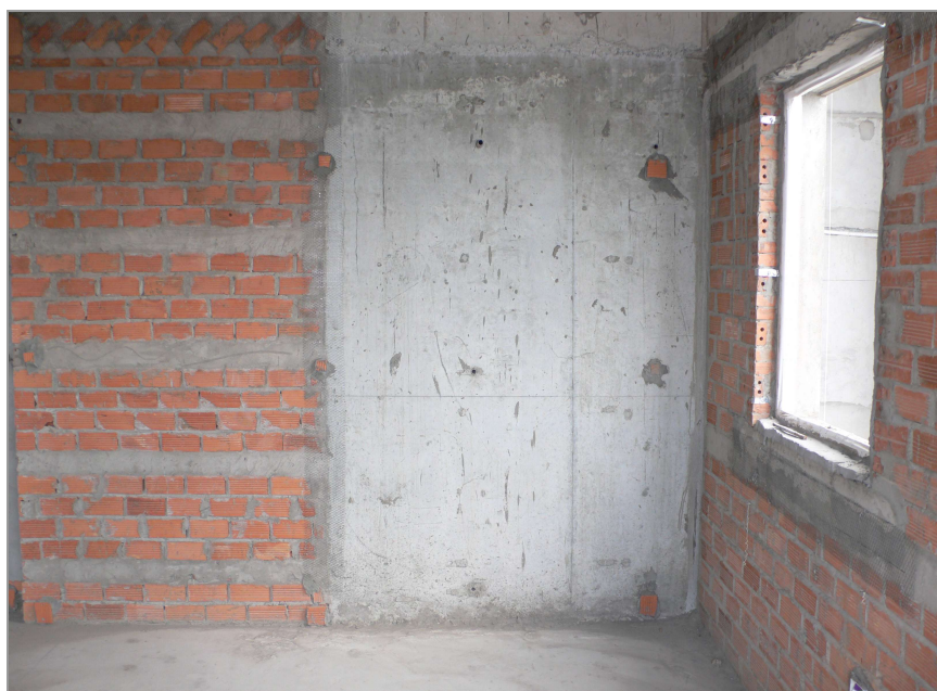
Các móc trát được phân bố thành hàng trên tường. Các móc trát phải nhẵn mặt và có kích thước 5cm-5cm.
