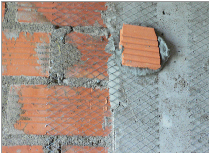
Mắc trát gắn trên tường.
