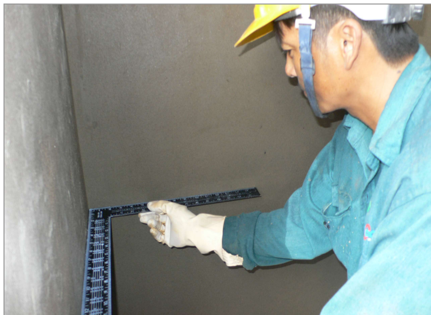
Dùng thước ke sắt kiểm tra các góc tường sau khi trát.
