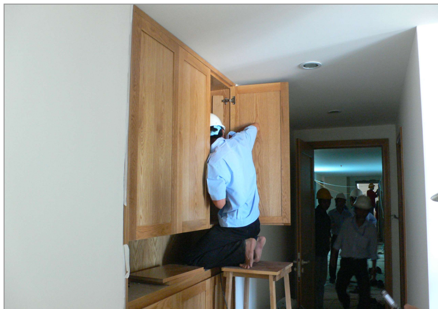
Lắp tủ âm tường.
