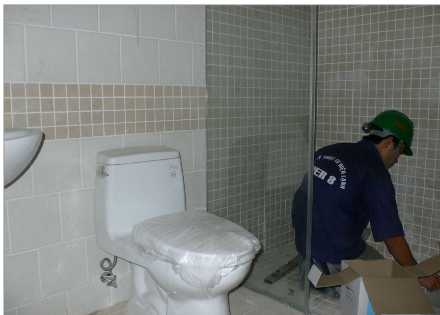
Lắp thiết bị vệ sinh trong toilet. Phải bao bọc các thiết bị sau khi lắp đặt để tránh trầy xước bề mặt.
