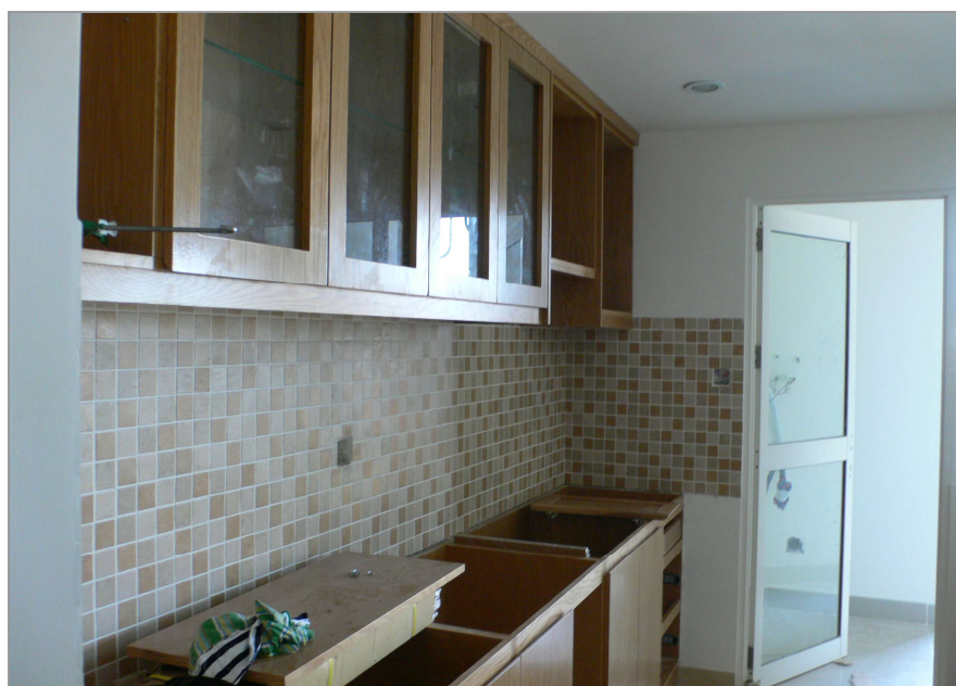
Lắp tủ kệ bếp.
