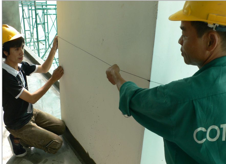
Bức tường được búng mực với cao độ chuẩn +1 m.
