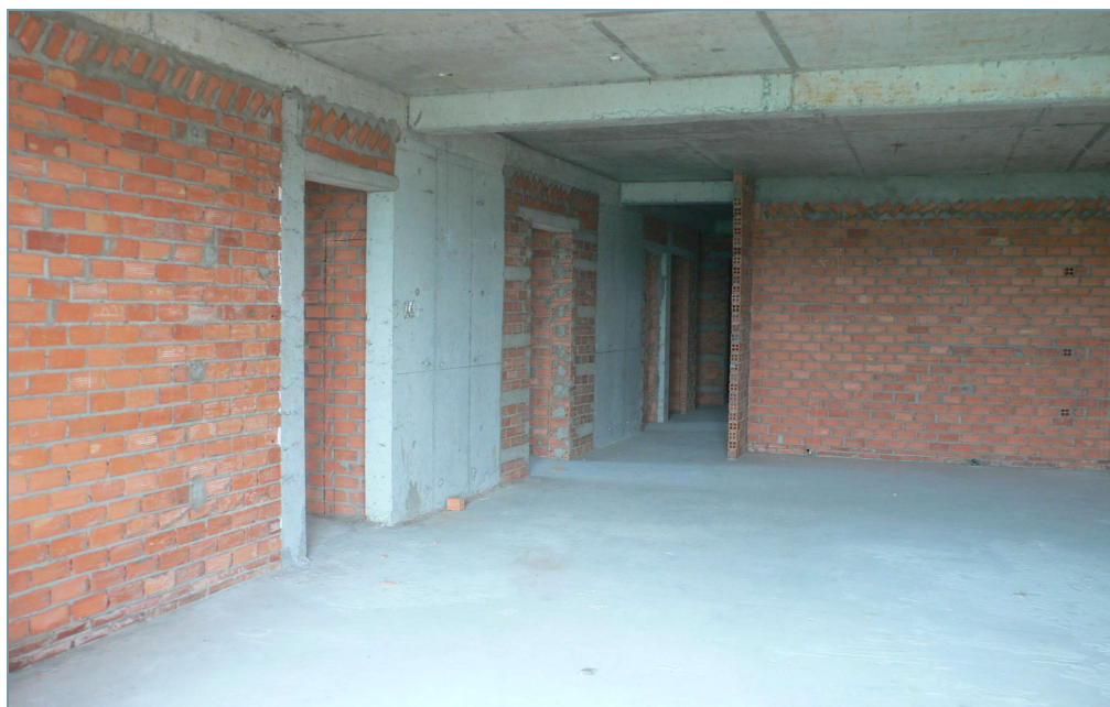
Tường được xây phải đảm bảo các chỉ tiêu về chất lượng, sàn bê tông phải được vệ sinh sạch sẽ, khô ráo.
