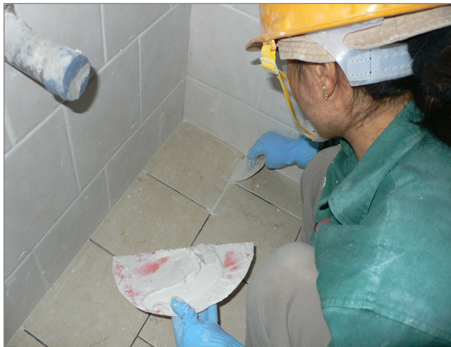
Lau chùi mặt sàn, miết mạch (joint).
