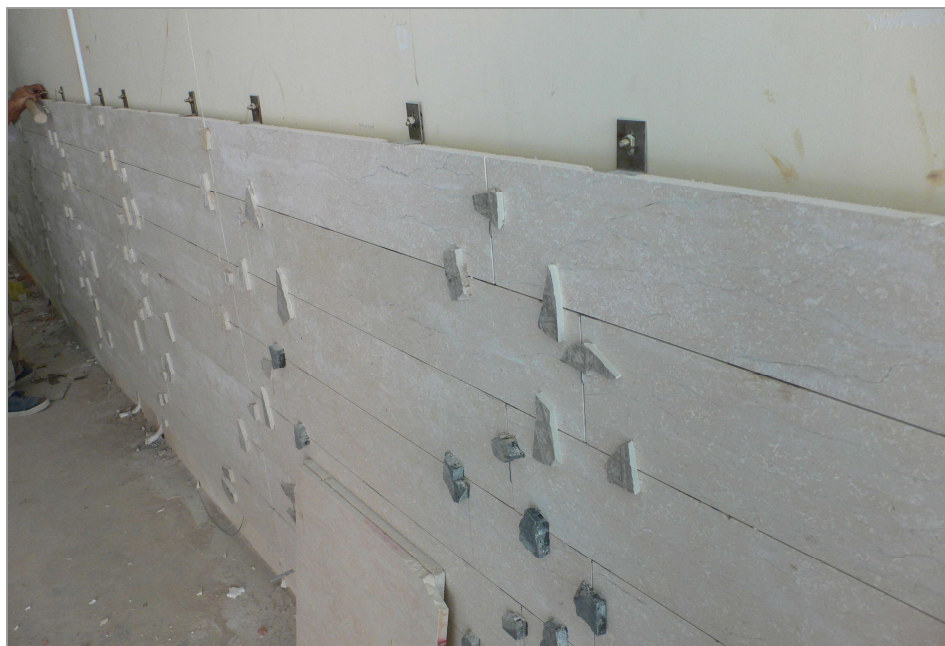
Đá tấm dày 20mm đang ốp lên tường với hàng loạt móc sắt (bát)
