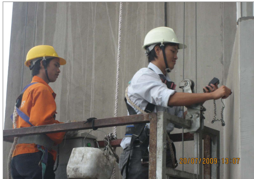
Kiểm tra độ ẩm tường trước khi bả mastic.
