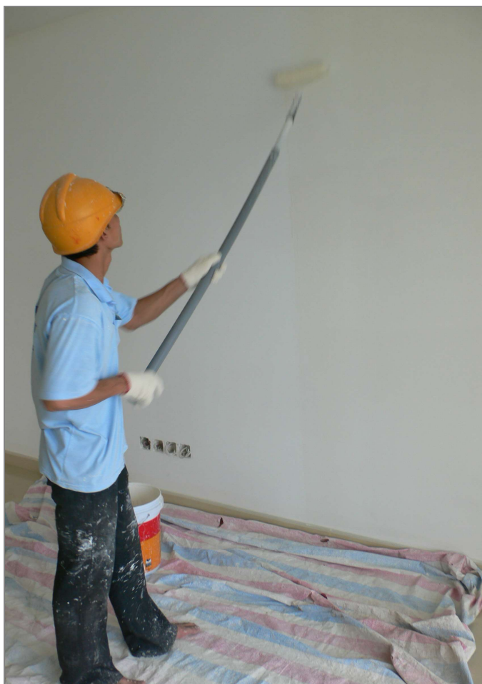
Vệ sinh mặt tường ,lăn sơn lót.
