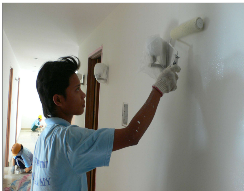
Khi lớp sơn lót khô,lăn các lớp sơn hoàn thiện.
