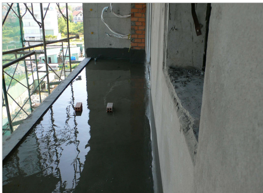
Ngâm nước kiểm tra màng chống thấm.
